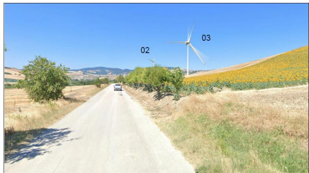
FOTO F3 - WTG 3 POST OPERA
