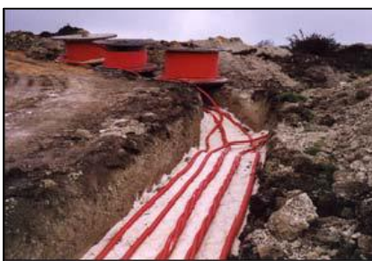
Figura 1 – Posa dei cavidotti interrati
