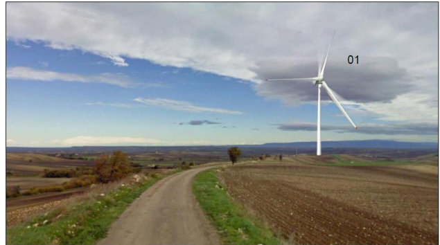
FOTO F1 - WTG 1 POST OPERA
