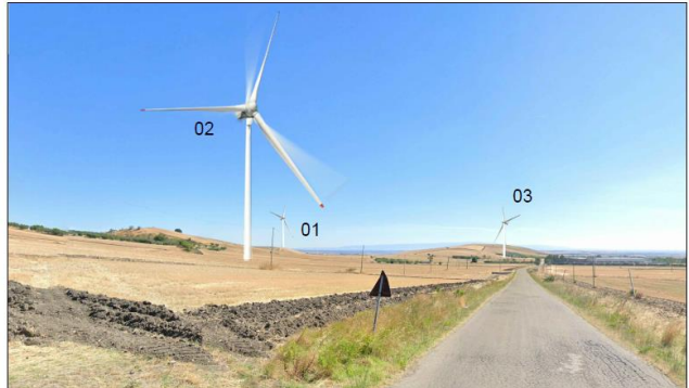
FOTO F2 - WTG 2 POST OPERA
