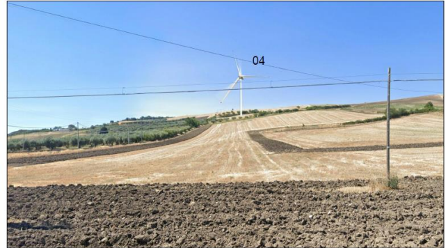
FOTO F4 - WTG 4 POST OPERA
