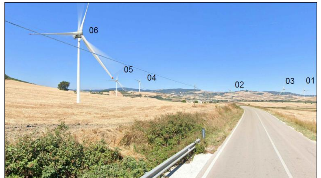
FOTO F6 - WTG 6 POST OPERA
