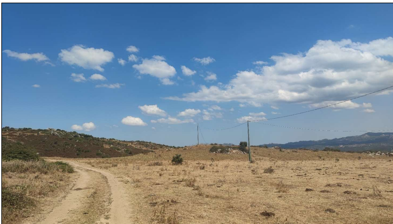
Foto 8.4: vista su area piazzola di montaggio dell'aerogeneratore GA10
