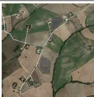
Impianto C e D
