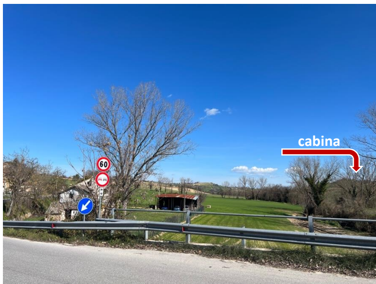
Scatto 28.2 Prospettiva dal fiume Potenza verso la cabina
