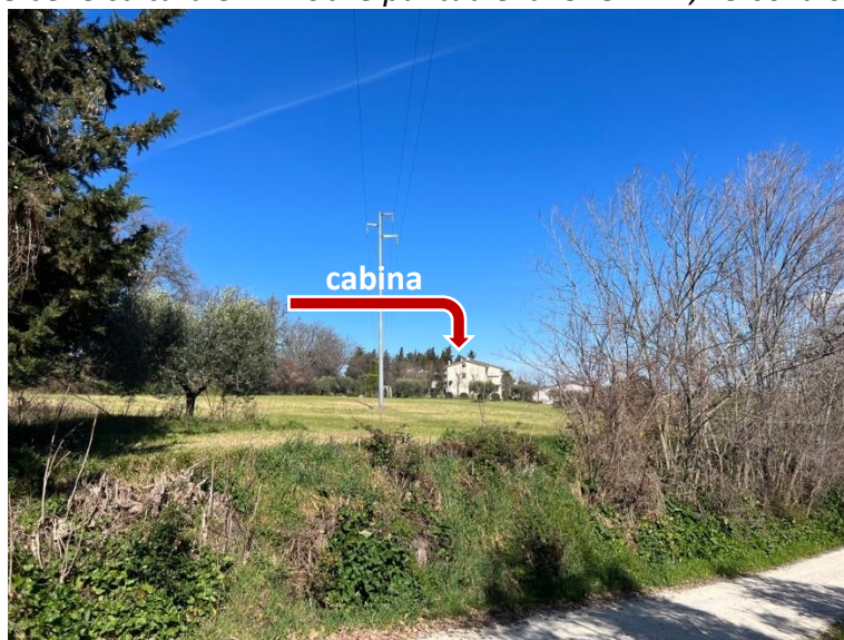
Foto 20 Prospettiva dal bene "S. Giuseppe", censito da VIR come bene culturale immobile puntuale id. 193699, verso la cabina
