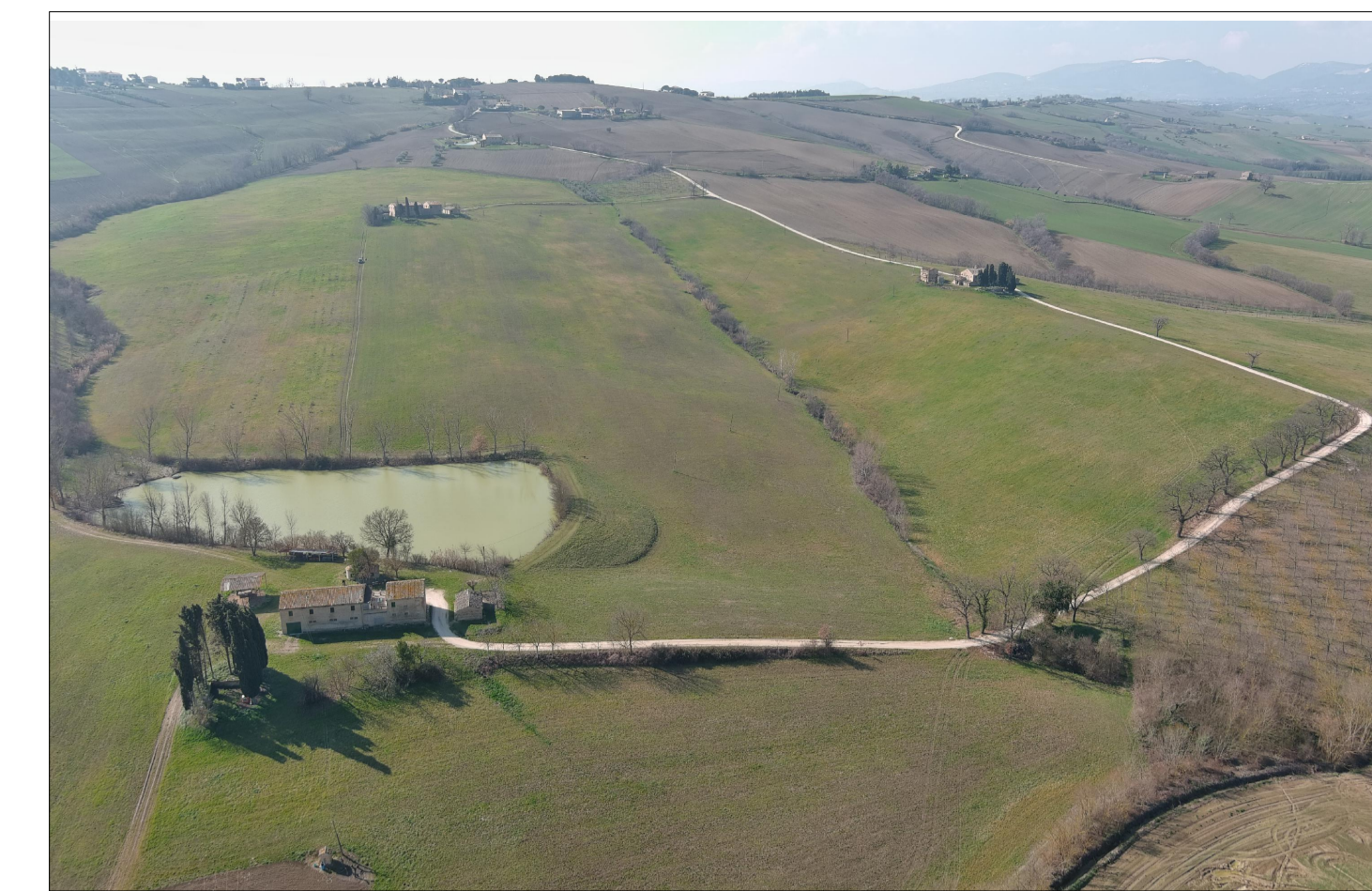
FOTO 5 - AREA DEL SITO STATO ATTUALE
