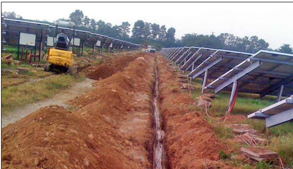
Figura 17 – Tipico di scavo per cavi BT/MT
