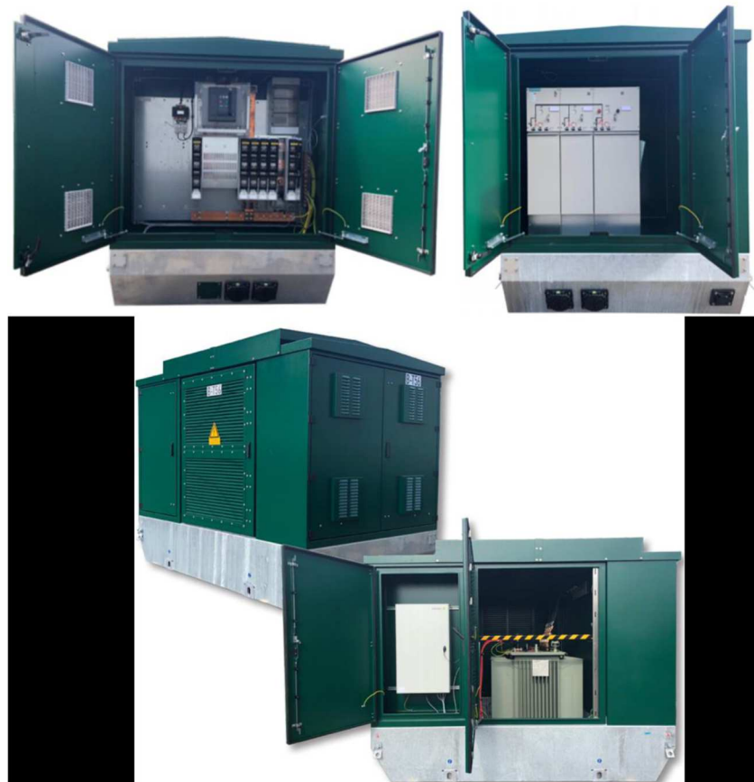
Fig. 22. Trasformatore da 1600 kVA BT/MT
