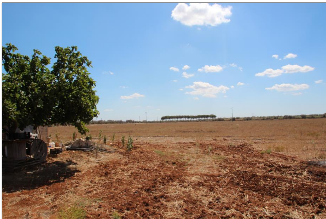
Foto demolizione n. 4 – Rudere
