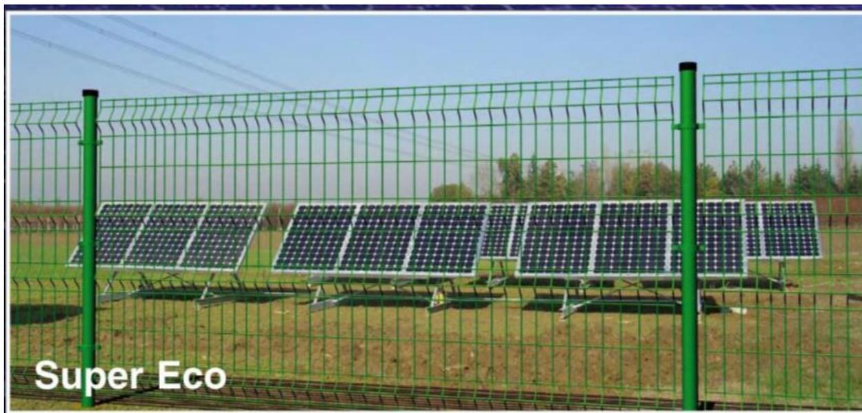
Fig. 1.12: Tipico della recinzione perimetrale (in quella installata sarà sempre lasciata una luce libera di 10 cm da terra)
