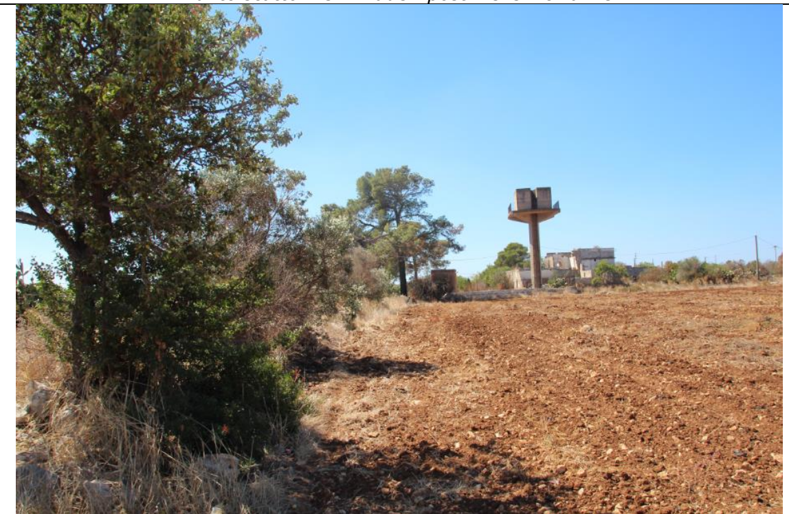
Punto scatto n.34: Serbatoio pensile a scopo irriguo
