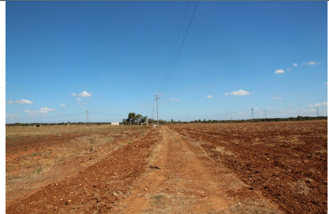
Punto scatto n.38: Linee elettriche aeree MT
