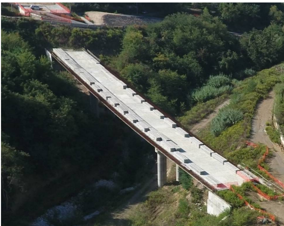
Figura 10 – Viadotto San Venerio II – Vista a fine cantiere da drone
