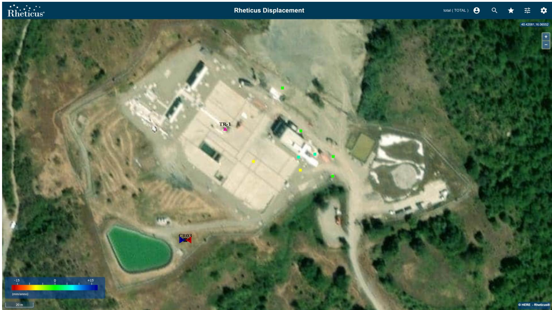
Figura 24: Pozzo TR-1 (indicato dal triangolo fucsia) Nel periodo esteso a Giugno 2021, non si evincono variazioni significative di velocità media rispetto al precedente rapporto [RD9][RD10]. Dai PS verdi presenti si evince come la parte est della piazzola non è influenzata dal fenomeno franoso situato a monte della stessa.
