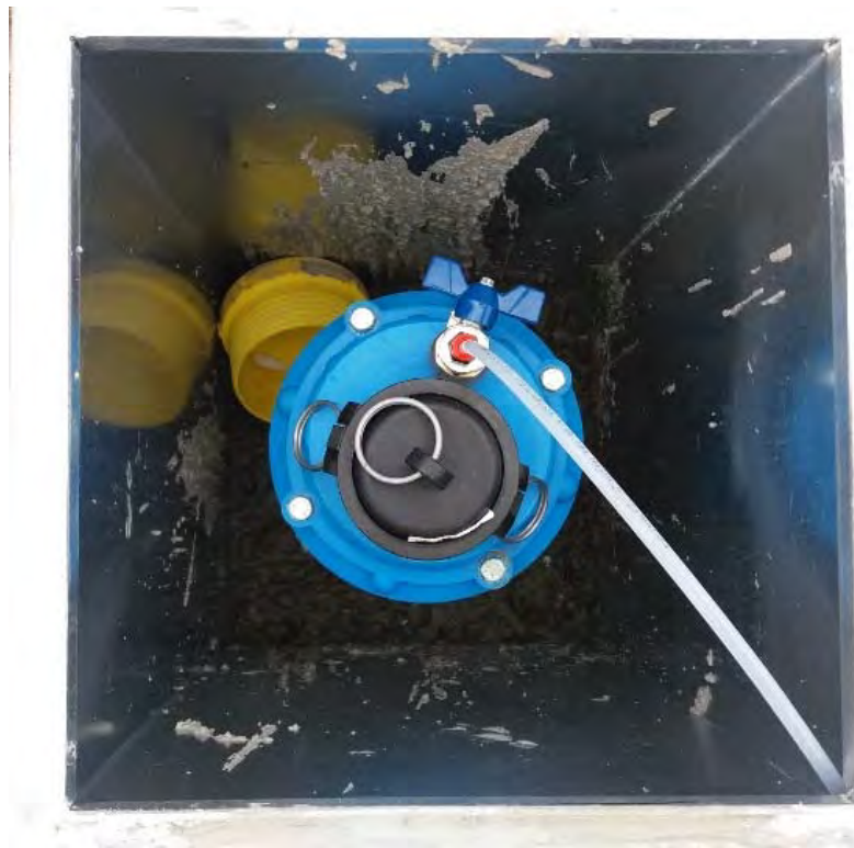
Fig. 1 - Testa pozzo a tenuta predisposta sui piezometri risultati “secchi”.
