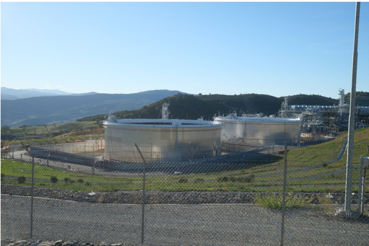
Figura 15: Immagine del Centro Olio di Tempa Rossa. Fonte: WSP Golder, 2022.
