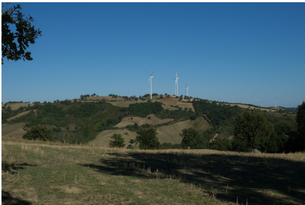
Figura 13: Immagine di un impianto eolico presente nell'Area Vasta. Fonte: WSP Golder, 2022.
