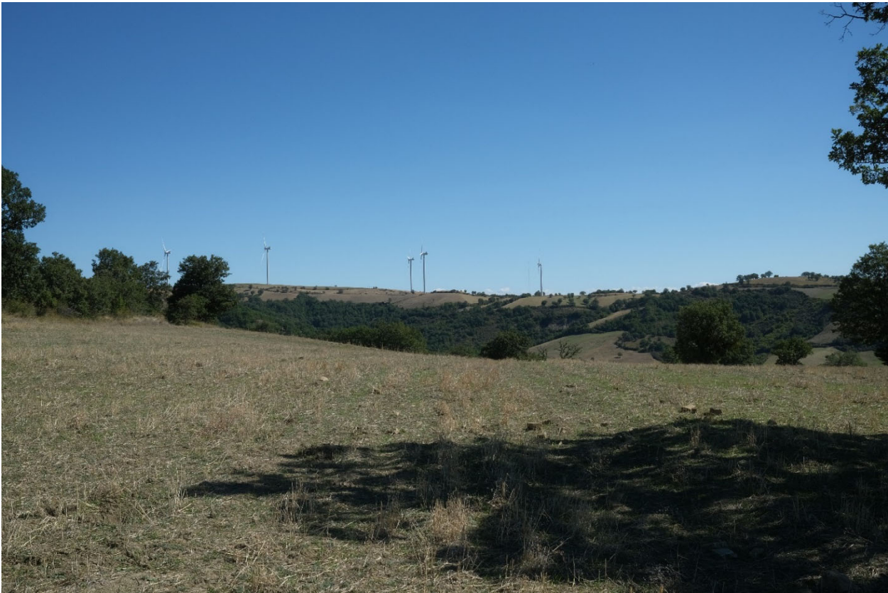
Figura 11: Immagine di un impianto eolico presente nell'Area Vasta. Fonte: WSP Golder, 2022.
