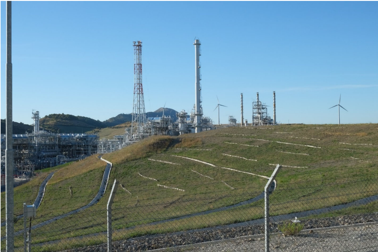
Figura 14: Immagine del Centro Olio di Tempa Rossa. Fonte: WSP Golder, 2022.
