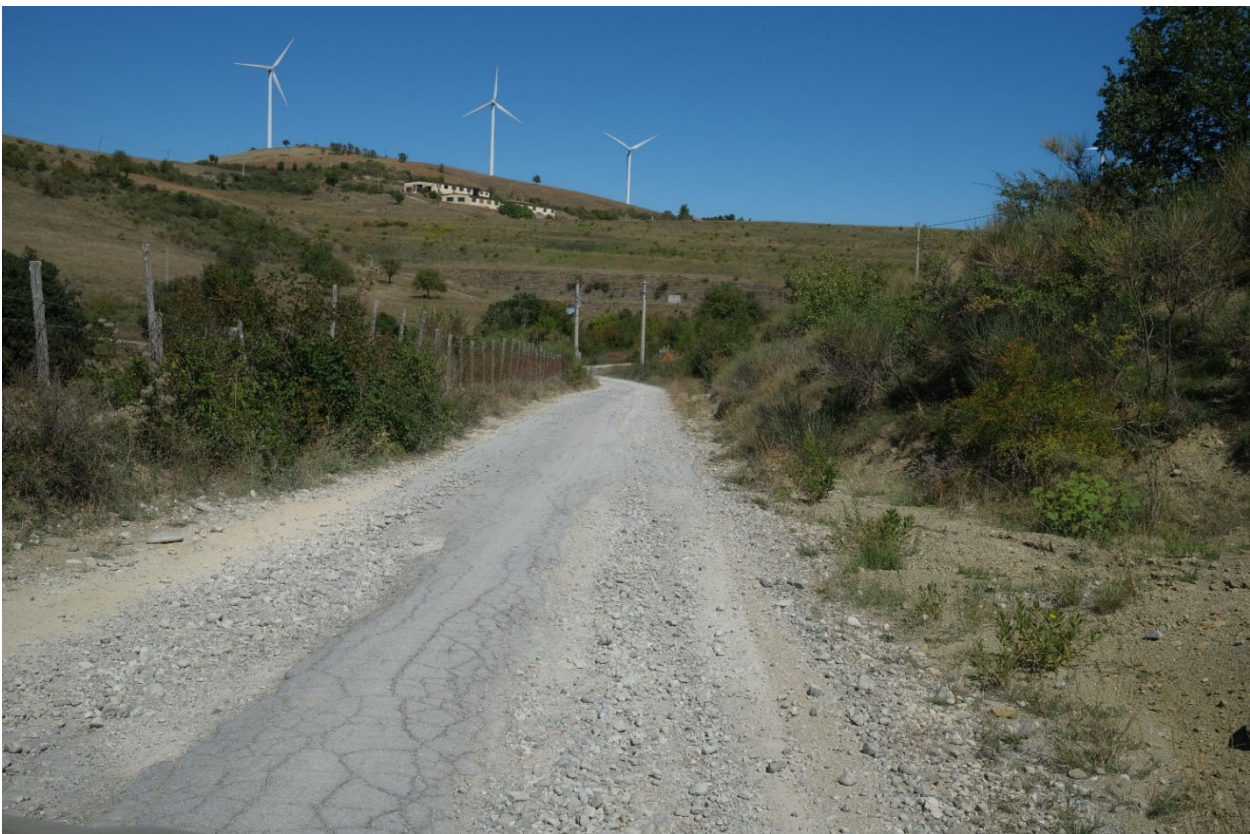
Figura 12: Immagine di un impianto eolico presente nell'Area Vasta. Fonte: WSP Golder, 2022.
