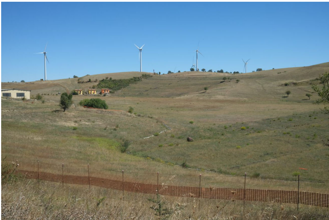
Figura 6 – Area di colmata
