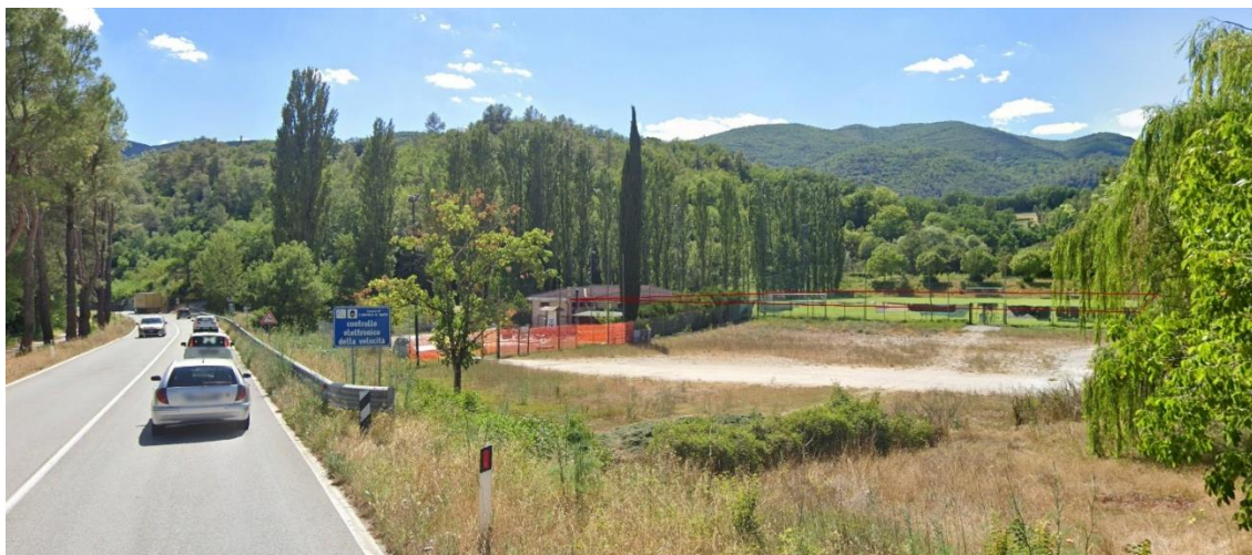
Figura 3-20 Visuale libera dell'area di cantiere da S.P. 209 direzione sud
