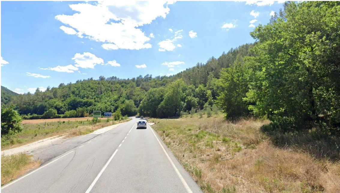
Figura 2-26 Ante operam all'altezza del km 50 della S.S. 685 in direzione Sant'Anatolia di Narco
