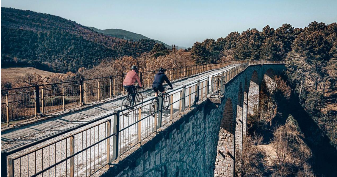
Figura 2-28 Uno dei numerosi viadotti che fanno parte del tracciato della ferrovia Spoleto – Norcia
