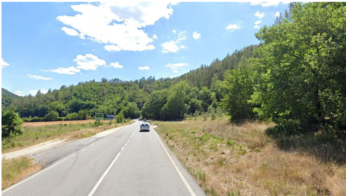
Figura 5-15 Ante operam all'altezza del km 50 della S.S. 685 in direzione Sant'Anatolia di Narco
