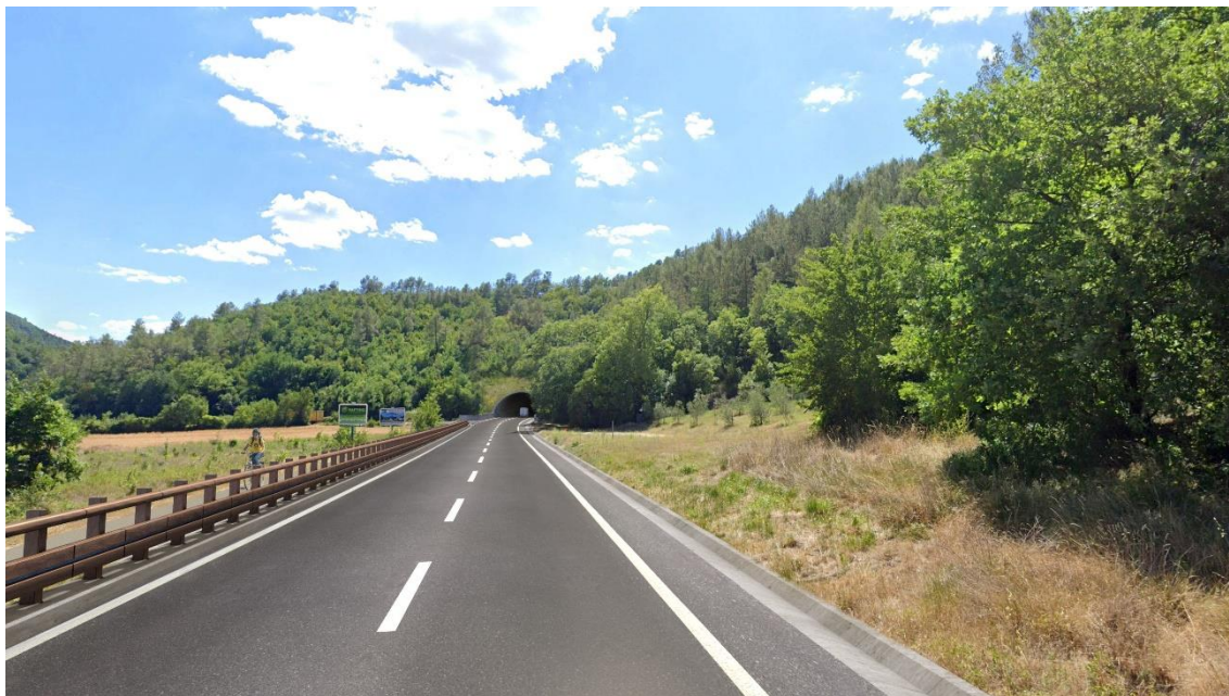
Figura 5-16 Post operam all'altezza del km 50 della S.S. 685 in direzione Sant'Anatolia di Narco
