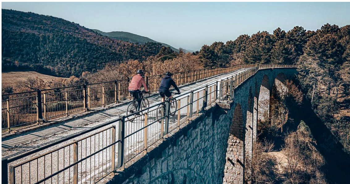
Figura 5-17 Uno dei numerosi viadotti che fanno parte del tracciato della ferrovia Spoleto – Norcia
