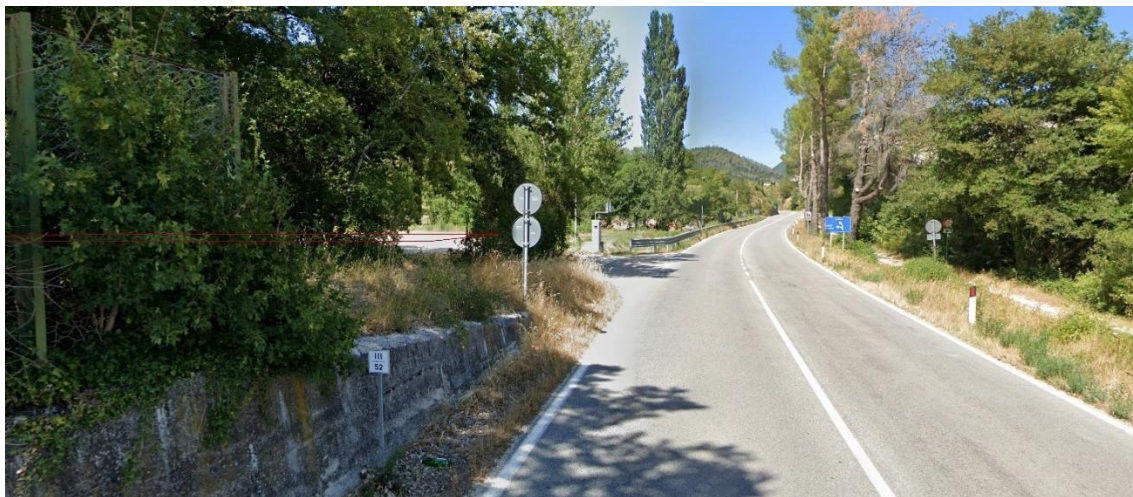
Figura 5-2 Visuale parziale dell'area di cantiere da S.P. 209 in direzione nord
