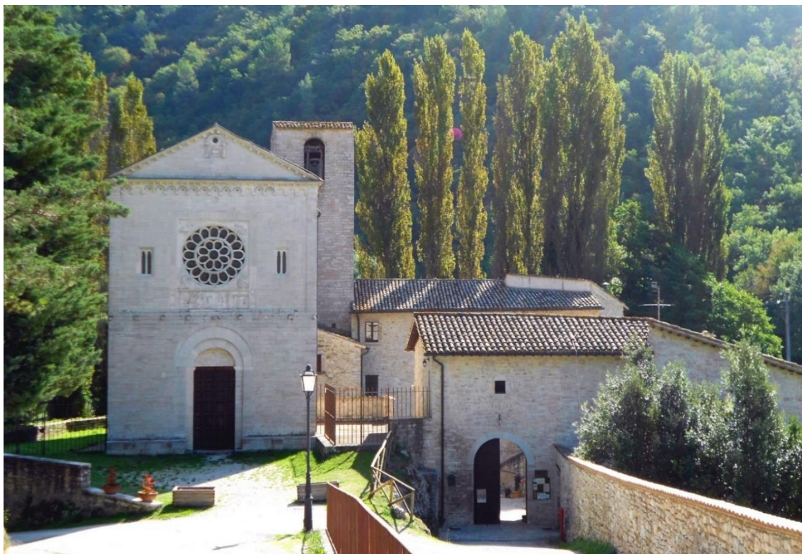
Figura 2-2 Chiesa abbaziale di San Felice di Narco
