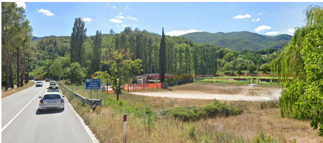
Figura 5-4 Visuale libera dell'area di cantiere da S.P. 209 direzione sud
