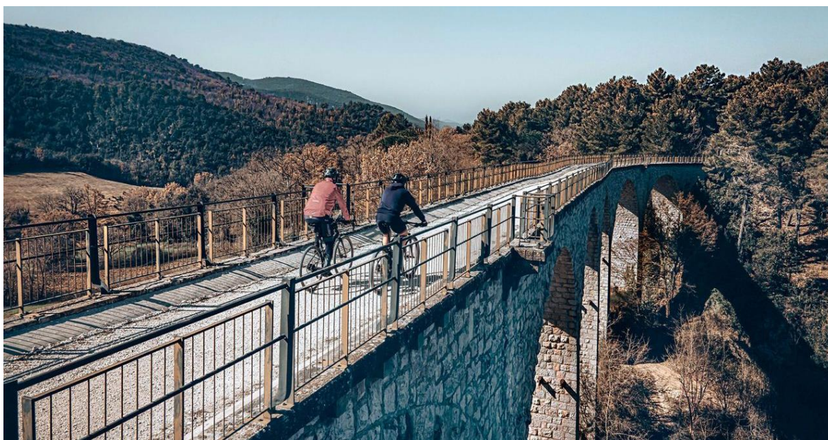
Figura 4-1 Uno dei numerosi viadotti che fanno parte del tracciato della ferrovia Spoleto – Norcia
