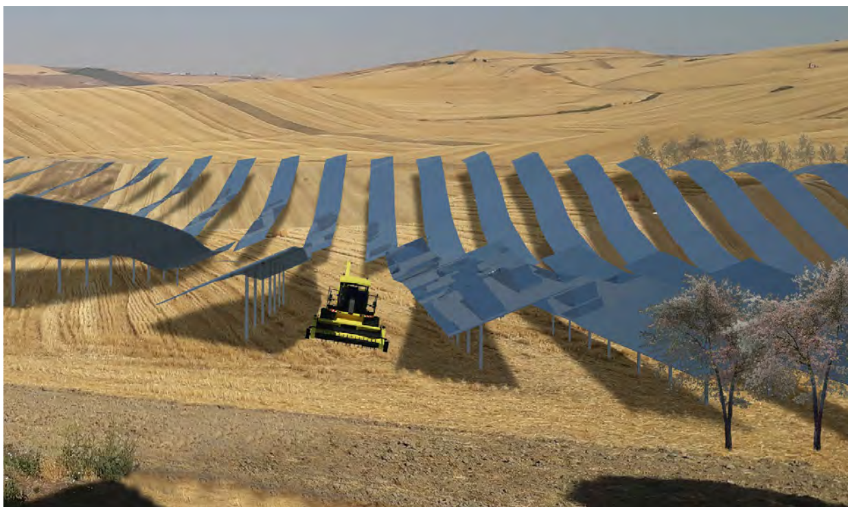
Vista interna all'impianto
