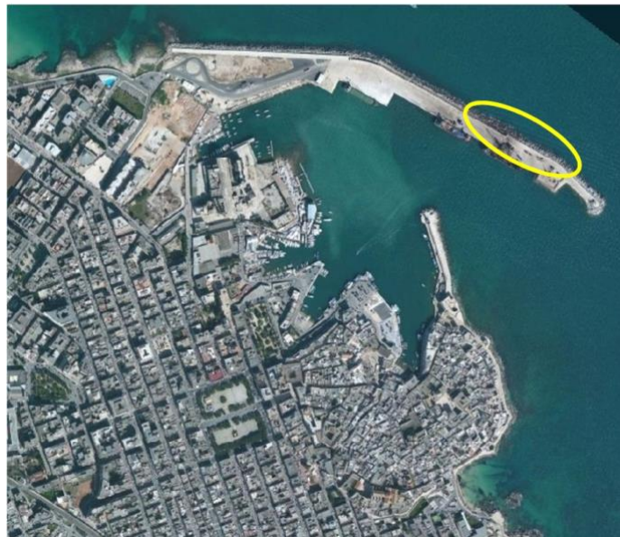
Vista aerea del Porto di Monopoli con evidenziata l'area di intervento delle opere "a mare"
