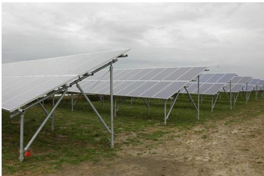
**Figura 14:** Esempio impianto a strutture fisse
