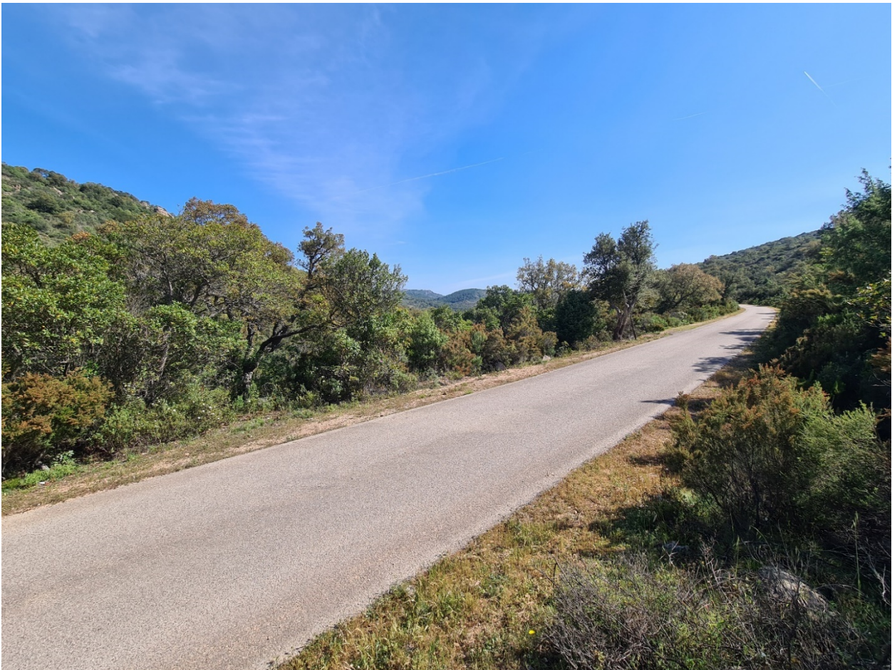
Foto 8b: Vista da strada di accesso alla WTG MA05 e alla WTG12
