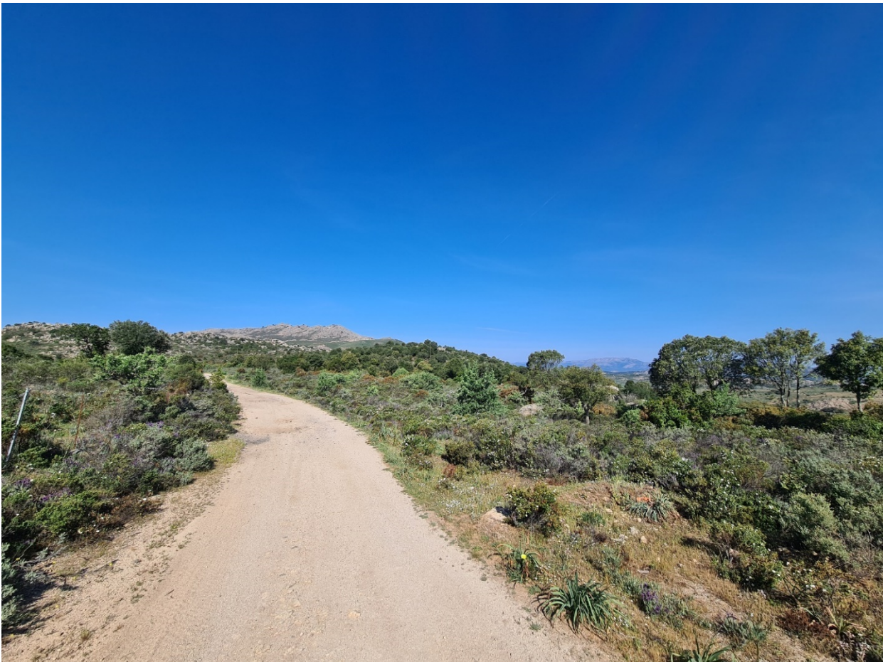
Foto1b: Vista da strada interna all'aerea della WTG MA06
