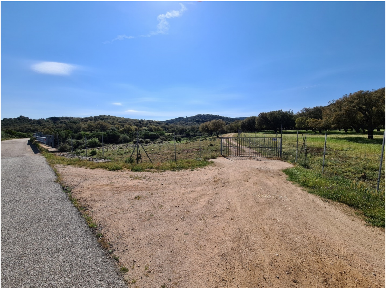
Foto 3a: Vista da strada di accesso alle WTG MA10 e MA12
