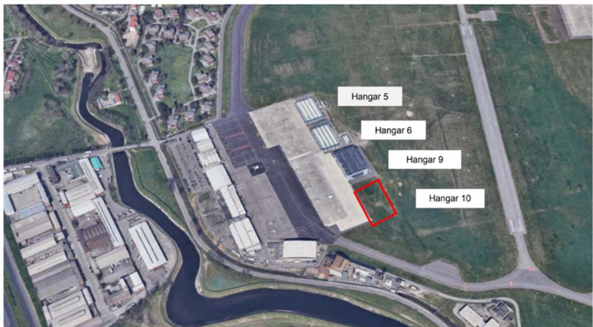
Figura 5.1 – Stato attuale dell'area e localizzazione hangar 10
