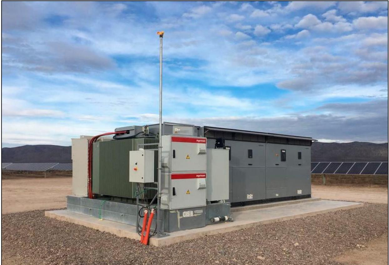
**Fig. 47: Cabine di trasformazione**
