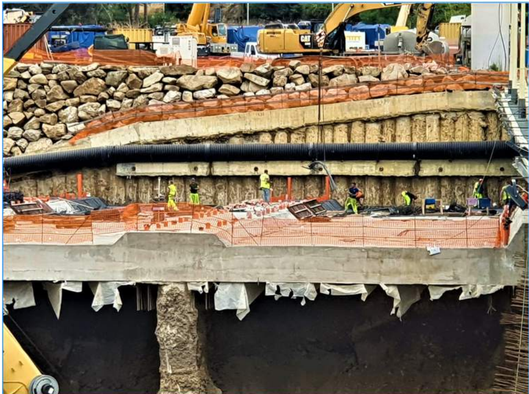
Figura 11 – Rimozione dei detriti
