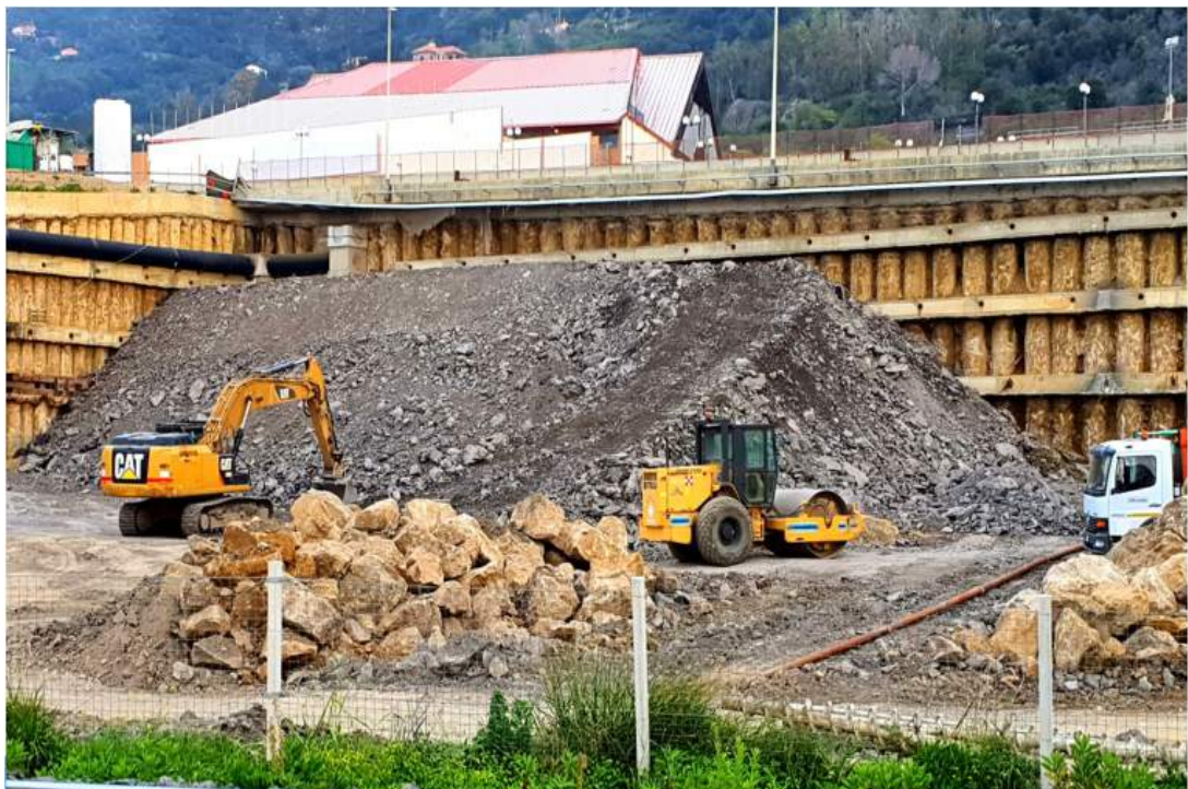
Figura 9 – Completamento della copertura
