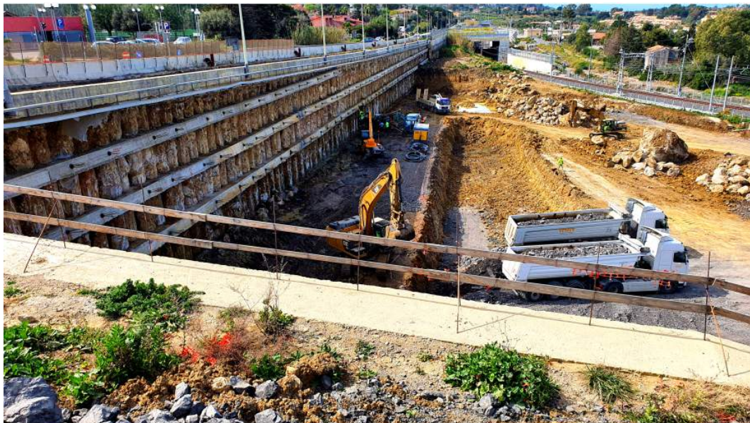
Figura 7 – Palificazione simile eseguita in località Ogliastrillo
