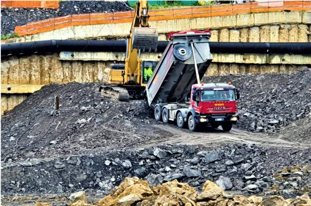
Figura 8 – Riempimento del passaggio a seguito di “Evento idrogeologico”
