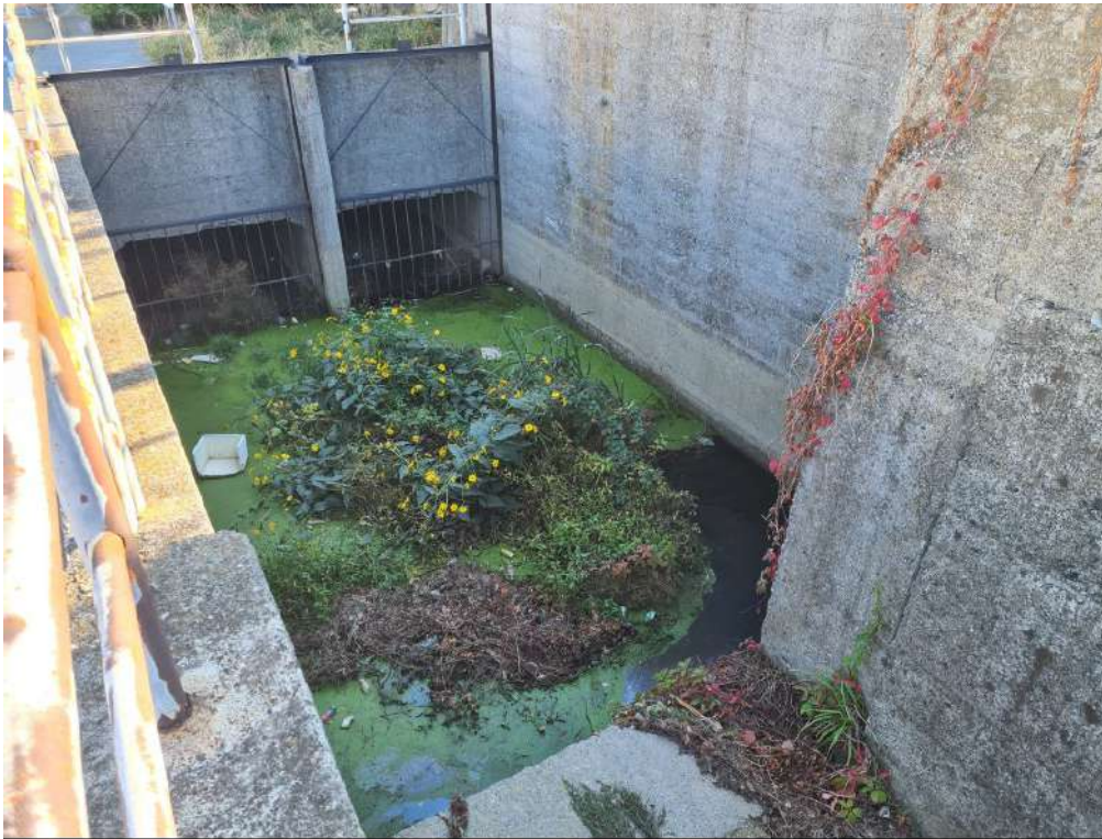
Manufatto di imbocco nello scatolare di scarico a mare, posizionato al termine del canale in fregio alla ferrovia
