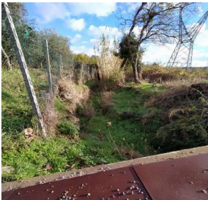
Alveo naturale del Fontanazza a monte autostrada A10
