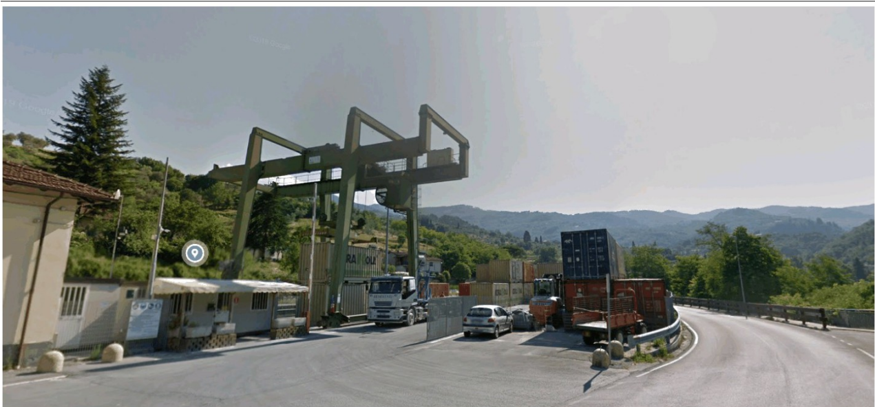
Illustrazione 2: Esempio di installazione gru transtainer a cavalletto (terminal di Minucciano (LU))
