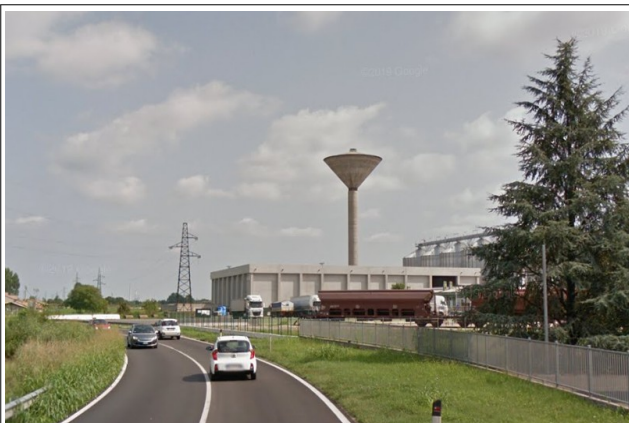
Illustrazione 11: foto pensile acquedotto e traliccio alta tensione
