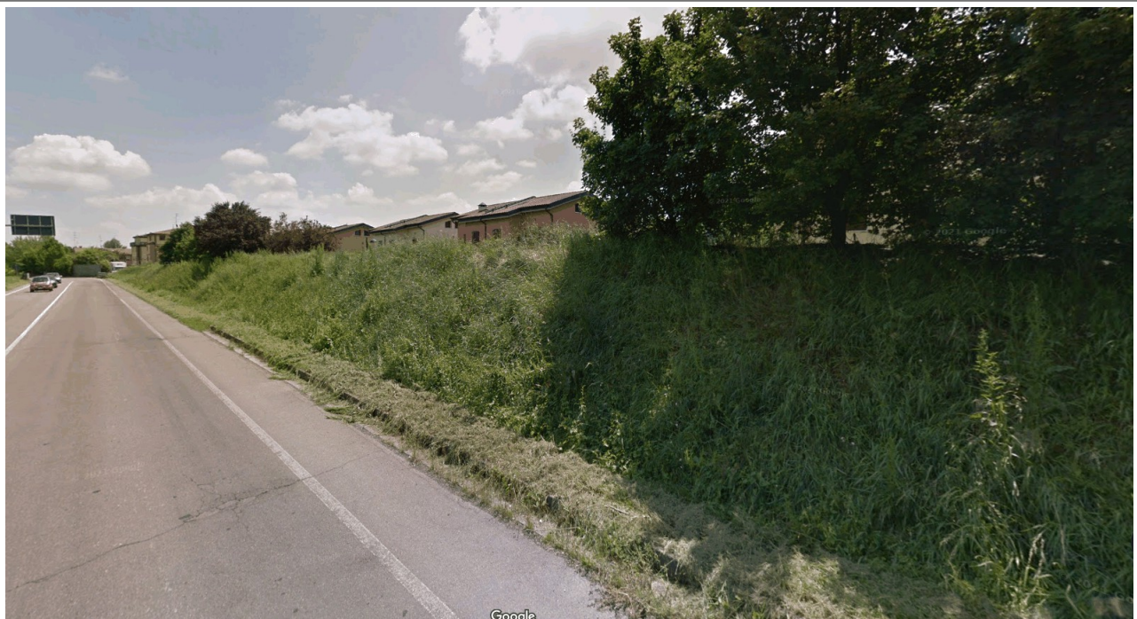
Illustrazione 26: Esempio di dosso in terra a margine stradale
