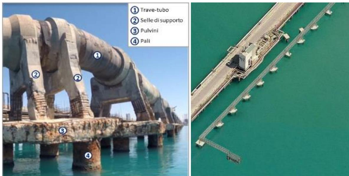
**Figura 3-9: A sinistra stato attuale della struttura, a destra Rendering della struttura in carpenteria metallica di supporto per la condotta di trasporto idrocarburi diametro 14"**
