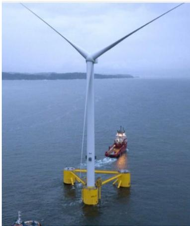
*Sottostruttura stabilizzata da figura di galleggiamento, tipo semisommersibile - WindFloat by Principle Power*
