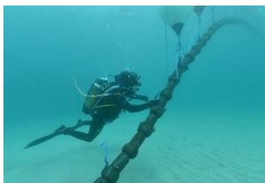
Posa in appoggio | gusci di ghisa – materassi - rocce
