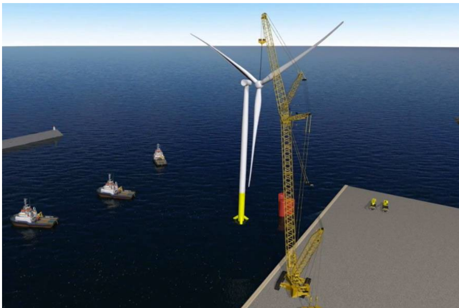
Montaggio di un aerogeneratore in banchina
