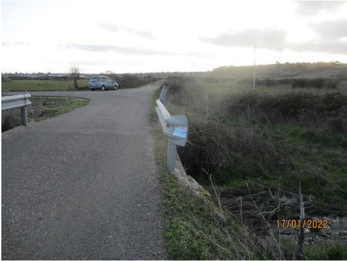
**Punto X1** – Ponticello su affluente del Rio Mene, da attraversare sotto alveo, previa posa di contro tubo con talpa teleguidata.
