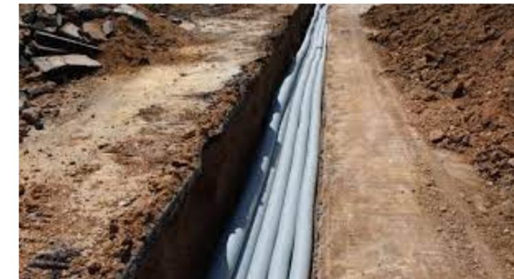
Mezzi d'opera: N.1 camion-gru da 10 t per lo srotolamento delle bobine ed escavatore per il trascinamento del cavo entro il cavidotto; operazione ripetuta in sequenza per le N.4 linee di cavo previste per ogni sezione di scavo
