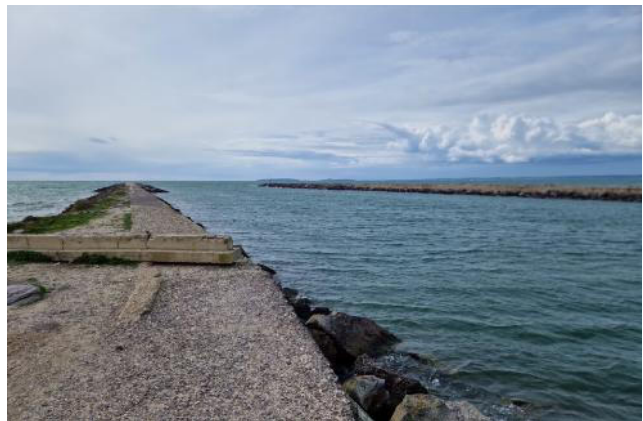
Foto 4 – Particolare delle opere di stabilizzazione della foce del Canale di Pesaria.
