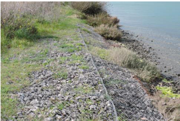
Foto 3 – Particolare delle opere di stabilizzazione in sponda sinistra del Canale di Pesaria.
