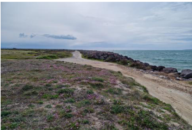
Foto 5 – Particolare delle opere di difesa spondale dell'area del Porto Industriale.
