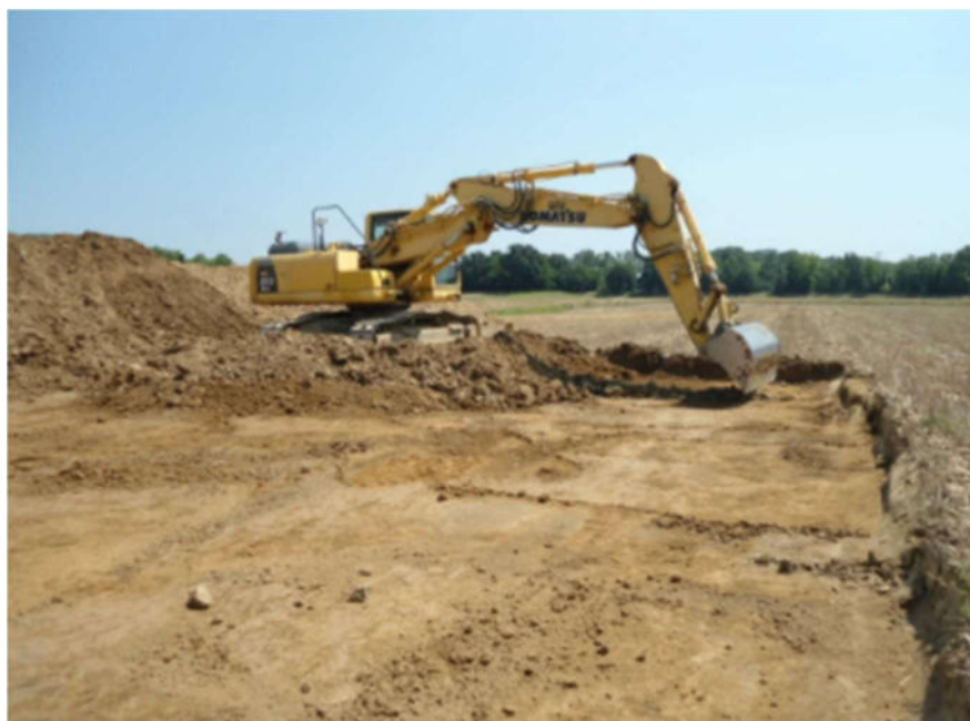
Figura 26: Particolare operazioni di scotico del terreno superficiale.
