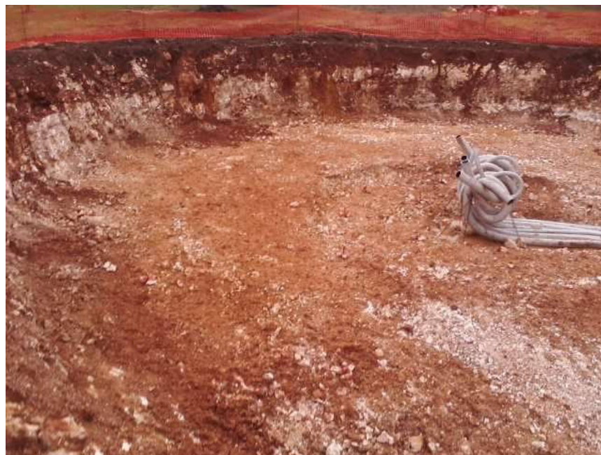
Figura 27: Particolare scavo di sbancamento per fondazioni WTG.
