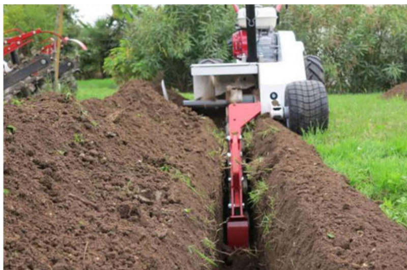
Figura 28: Particolare operazioni di scavo a sezione obbligata.
