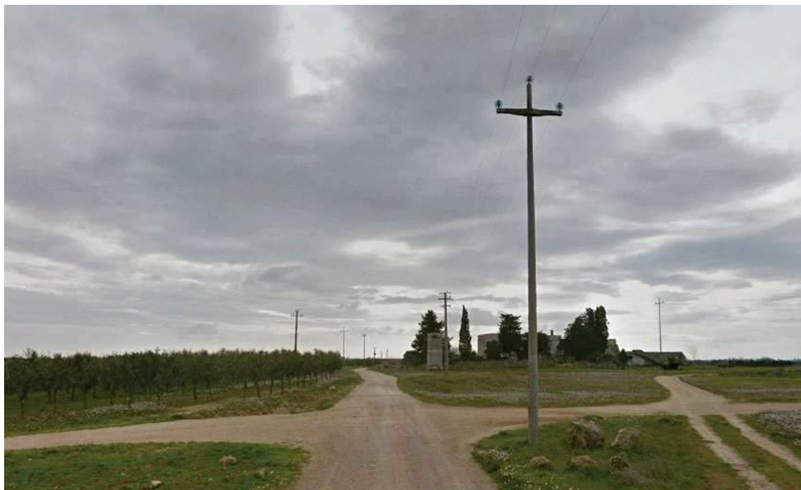
Figura 66: Masseria Morigine – UCP Segnalazione Architettonica PPTR
