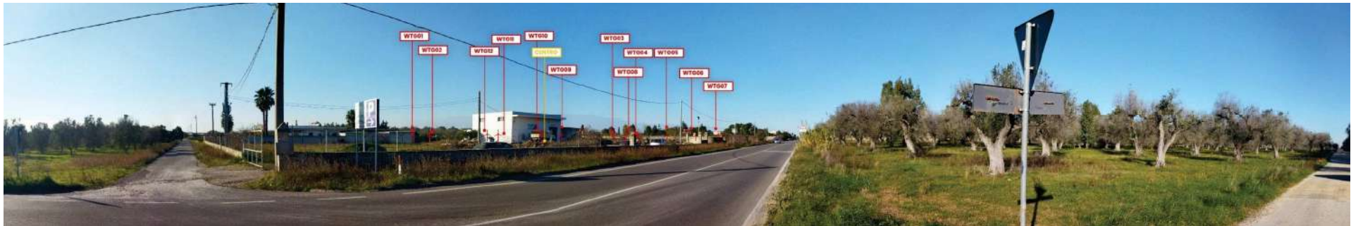
Figura 87: rispettivamente Foto della SDF e Fotosimulazione – Fotosimulazione con indicazioni da PV16: SP17 LE - Strade a valenza paesaggistica
