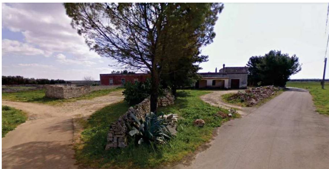
Figura 63: Masseria Falli – UCP Segnalazione Architettonica PPTR
