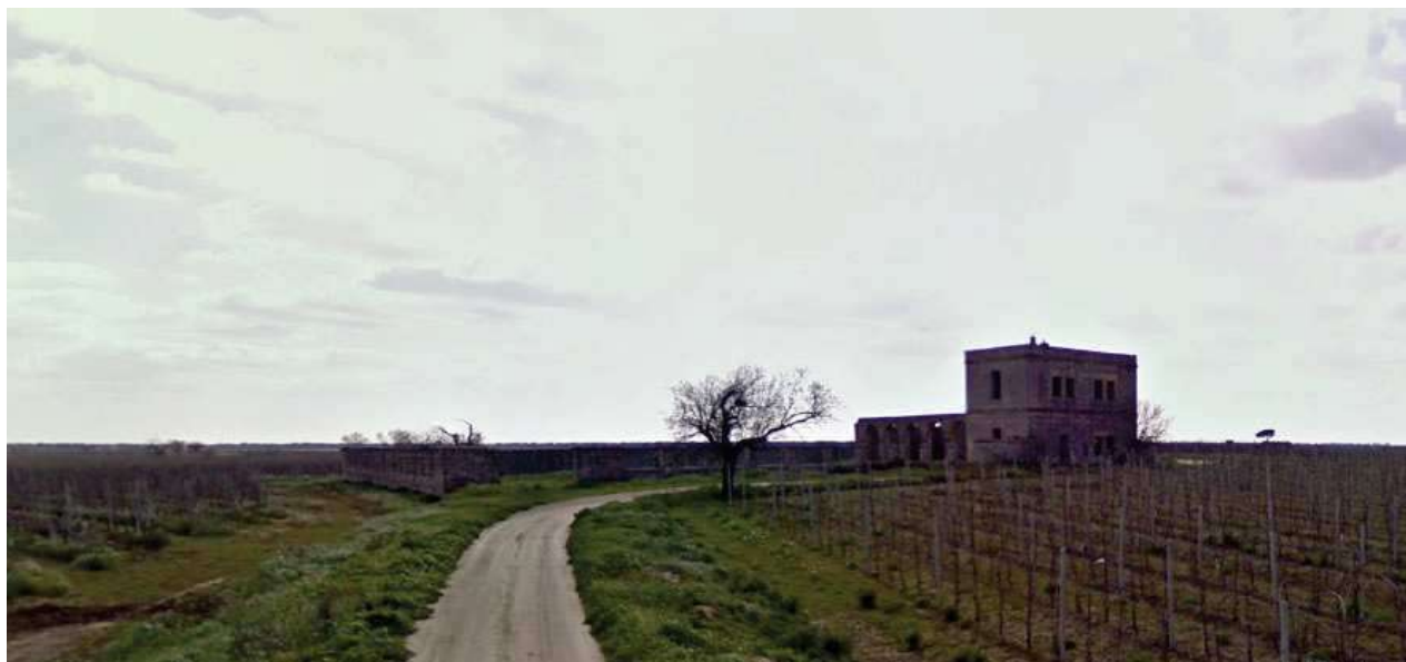
Figura 64: Masseria Paduli – UCP Segnalazione Architettonica PPTR
