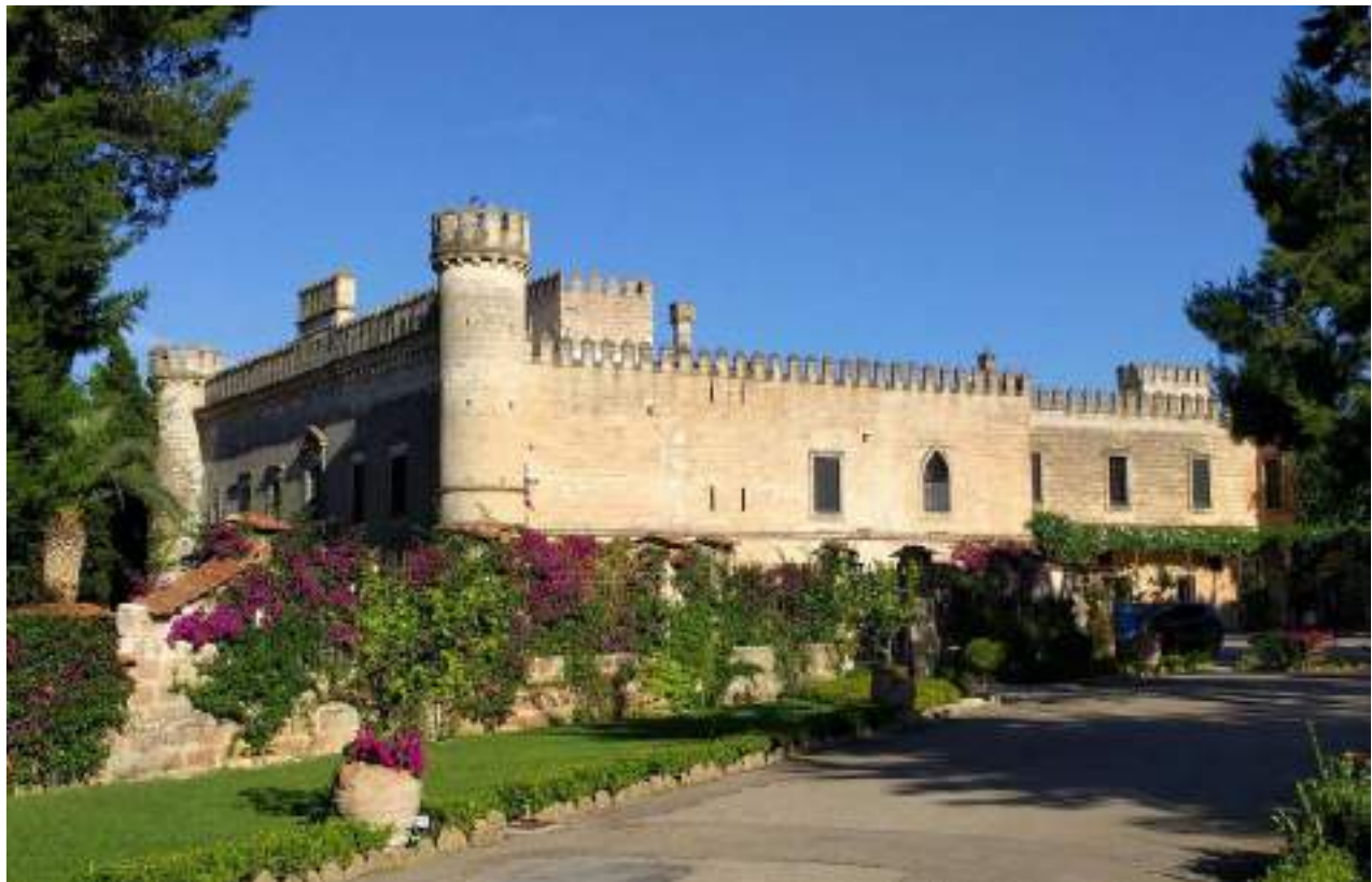
Figura 85: Masseria Castello Monaci – UCP Segnalazione Architettonica PPTR
