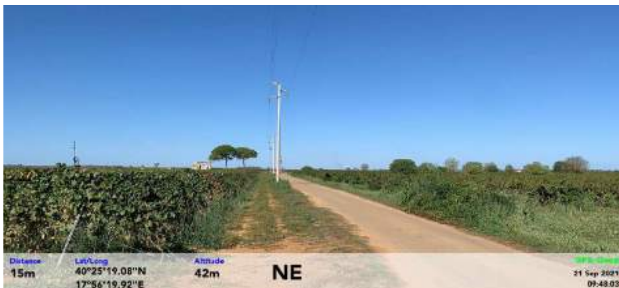
Figura 121 - Linea di media tensione lungo la strada San Donaci-Campi. Area per viabilità di nuova realizzazione sulla destra
