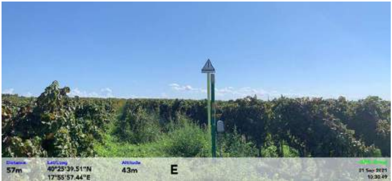
Figura 122 - Paletto di segnalazione del metanodotto
