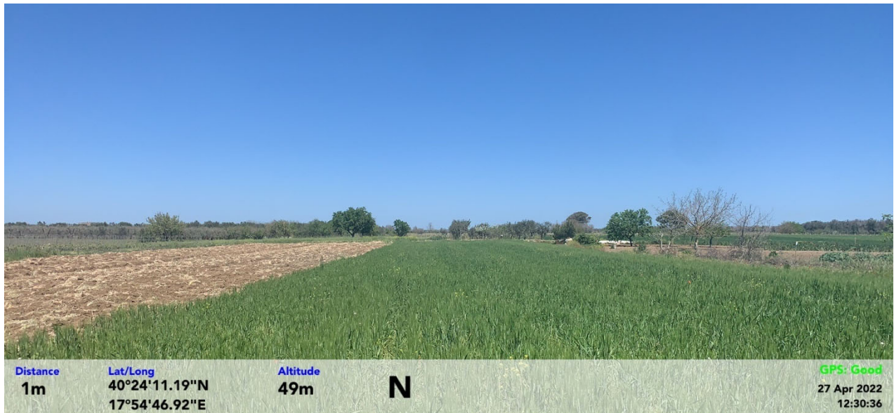
Figura 54 - Aerogeneratore GU-10, vista in direzione Nord
