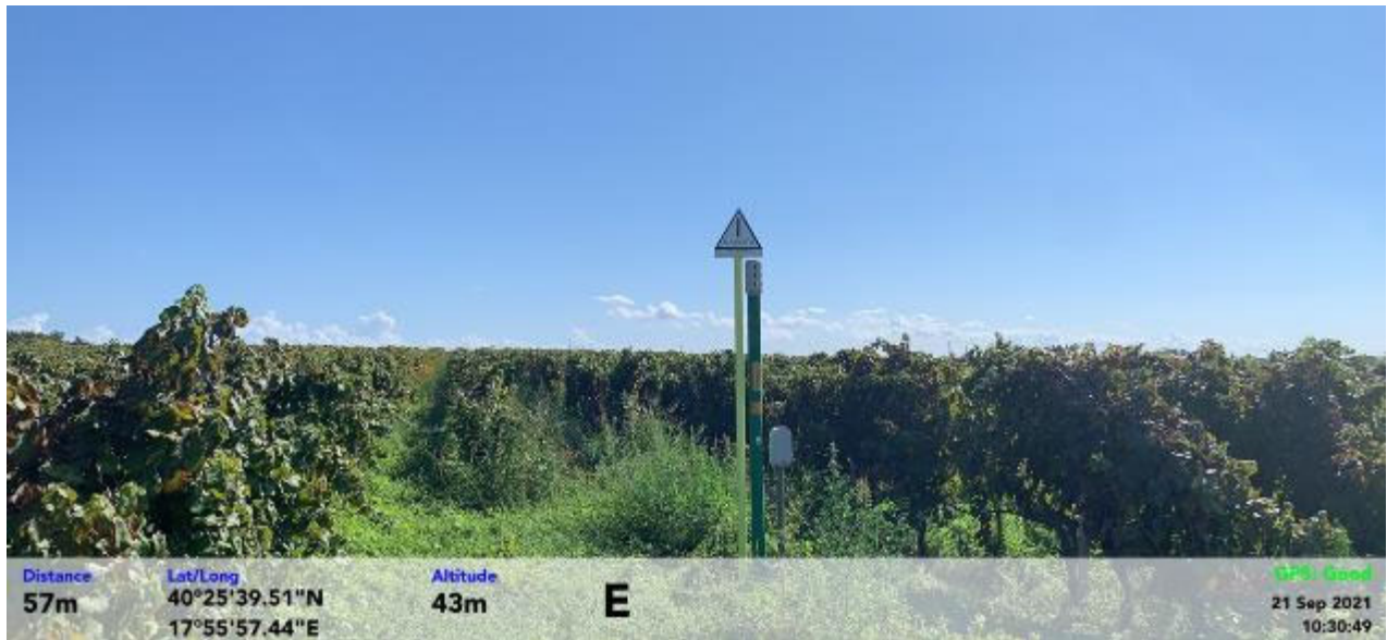
Figura 25 - Paletto di segnalazione del metanodotto
