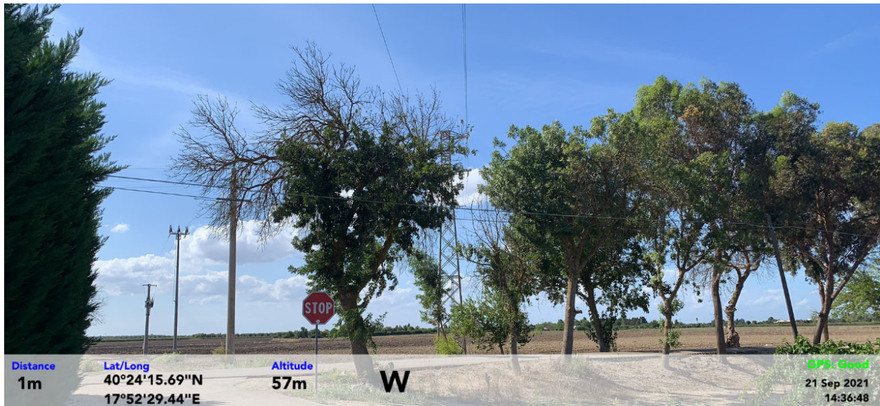
Figura 46 - Interferenza con linea di bassa e media tensione e con linea telefonica
