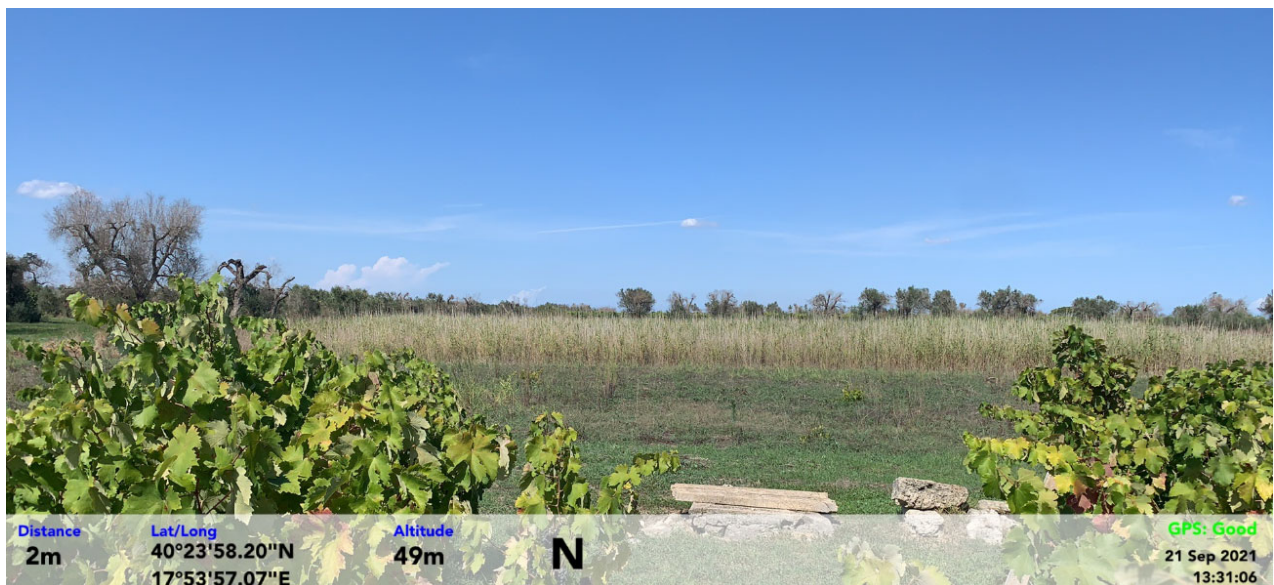
Figura 57 - Aerogeneratore GU-12, Vista in direzione Nord
