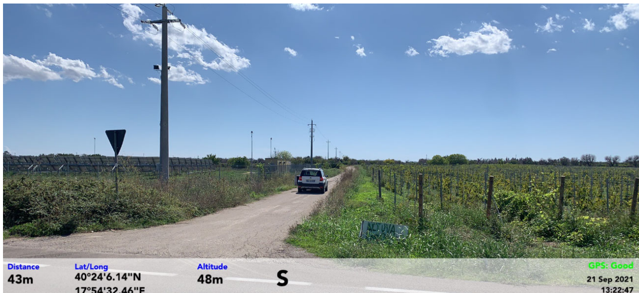
Figura 55 - Interferenza con la linea elettrica MT lungo a sinistra della viabilità esistente da adeguare
