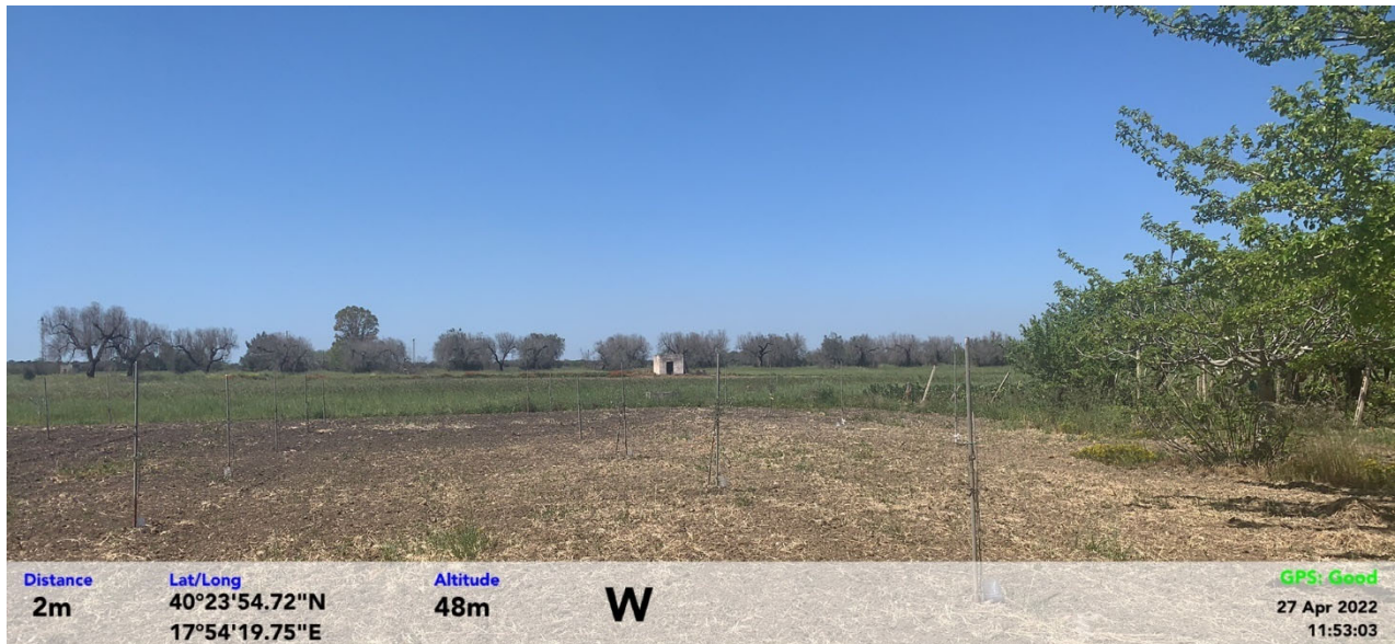
Figura 56 - Aerogeneratore GU-11, vista in direzione Ovest
