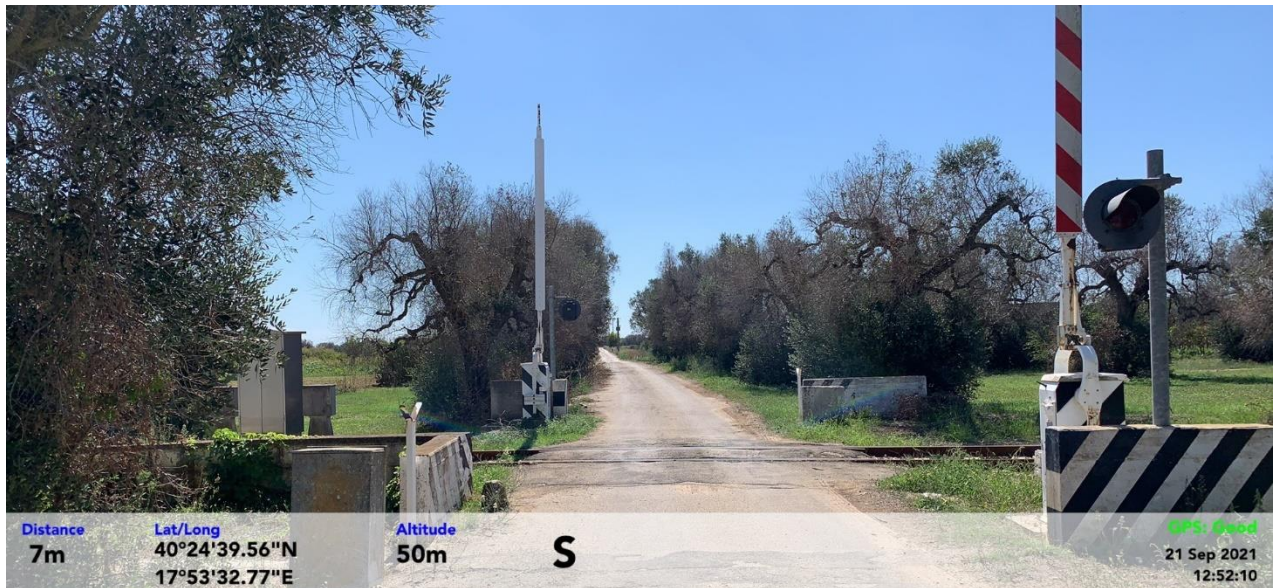
Figura 74: interferenza con linea ferroviaria lungo Strada Bosco
