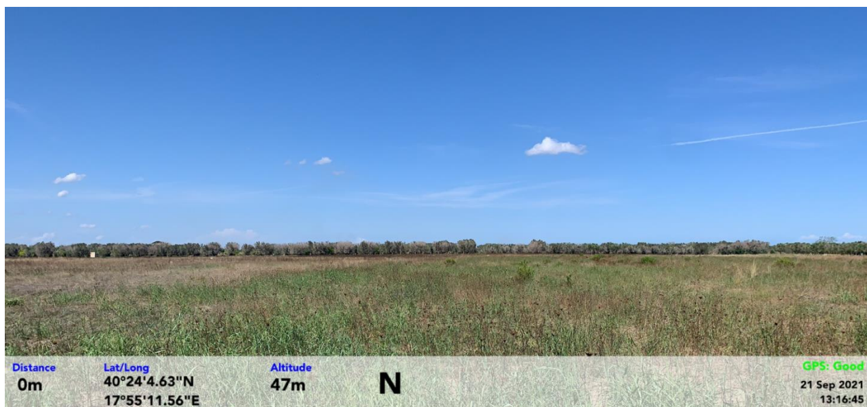
Figura 85 - Aerogeneratore GU-09, Vista in direzione Nord
