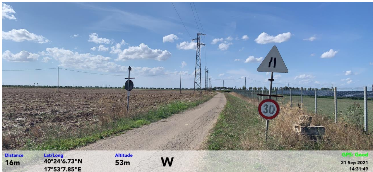
Figura 77 - Interferenza con linea di bassa e media tensione
