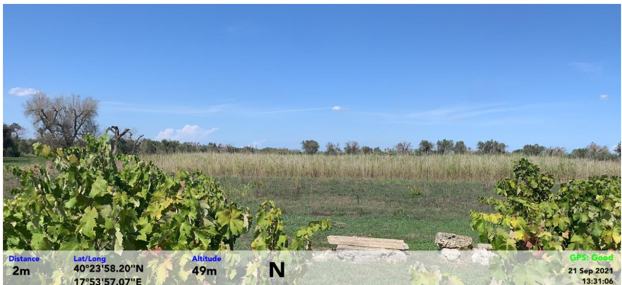
Figura 89 - Aerogeneratore GU-12, Vista in direzione Nord
