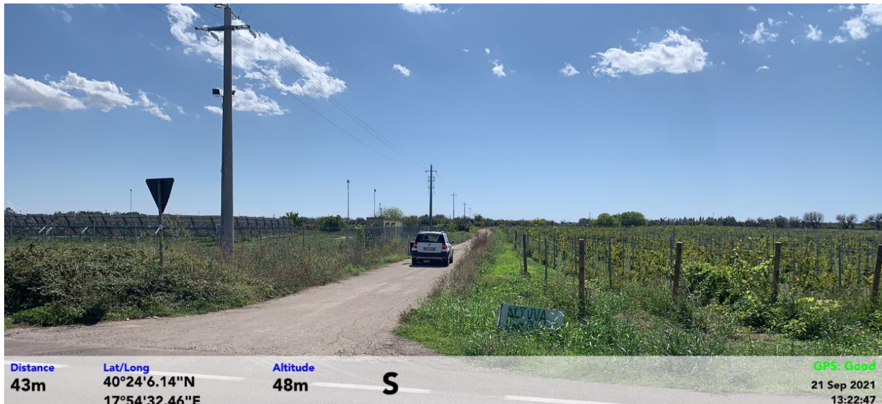
Figura 87 - Interferenza con la linea elettrica MT lungo a sinistra della viabilità esistente da adeguare
