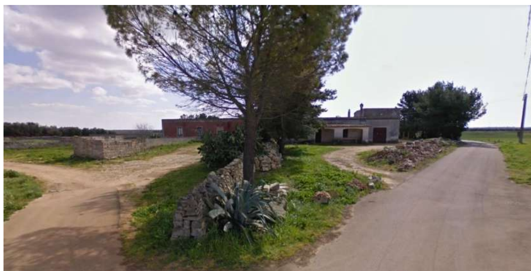
Figura 33: Masseria Falli – UCP Segnalazione Architettonica PPTR
