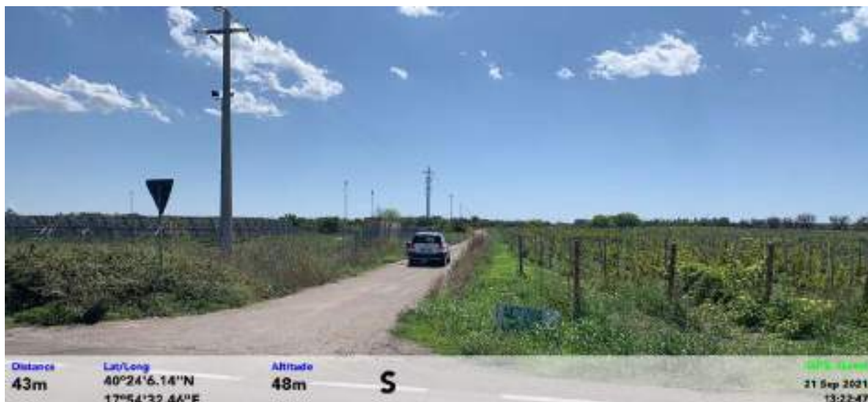
Figura 130 - Interferenza con la linea elettrica MT lungo la viabilità esistente da adeguare
