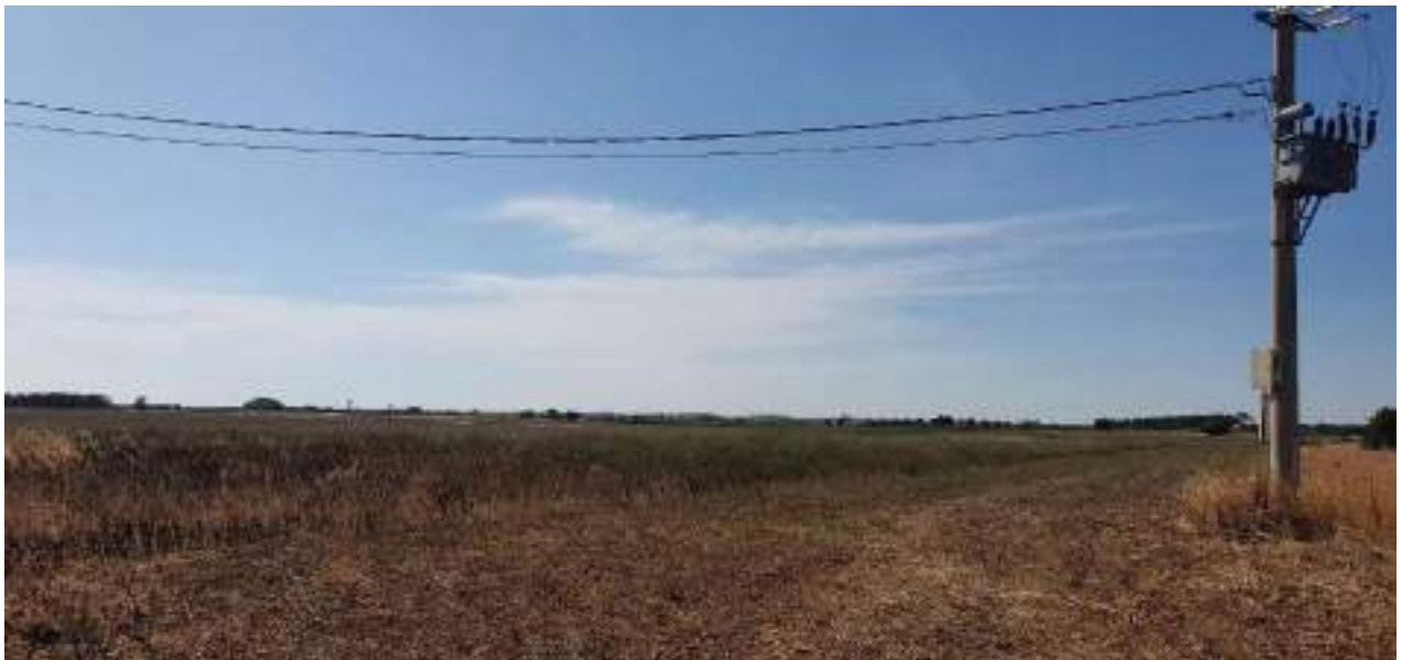
Figura 70: Vista in direzione della SSU-BESS
