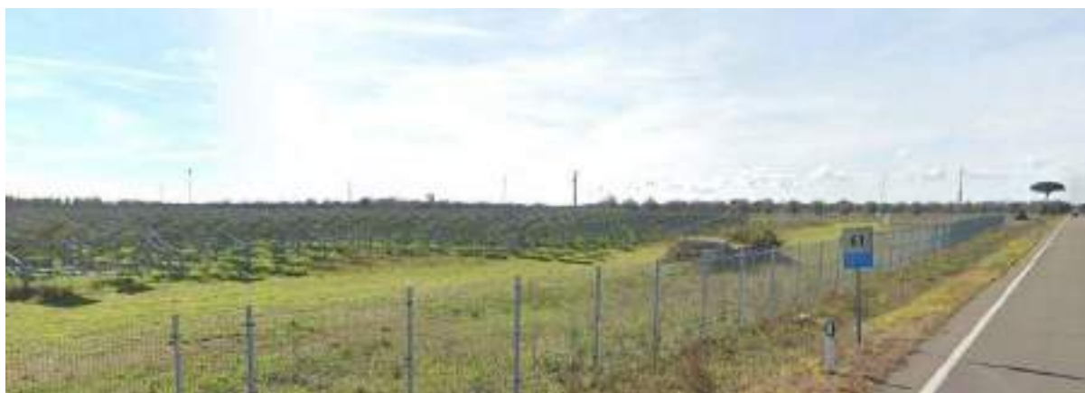
Figura 77: Foto SS7ter - Strada dei Vigneti -UCP "Strada a valenza Paesaggistica" PPTR – Particolare campo FV
