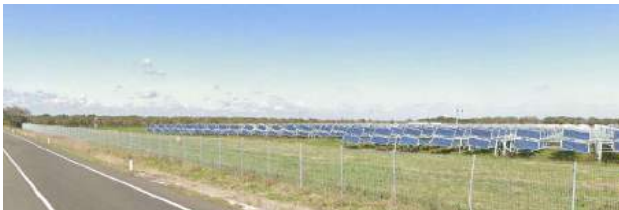
Figura 76: Foto SS7ter - Strada dei Vigneti -UCP "Strada a valenza Paesaggistica" PPTR – Particolare campo FV
