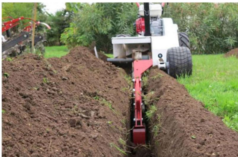
Figura 28: Particolare operazioni di scavo a sezione obbligata.
