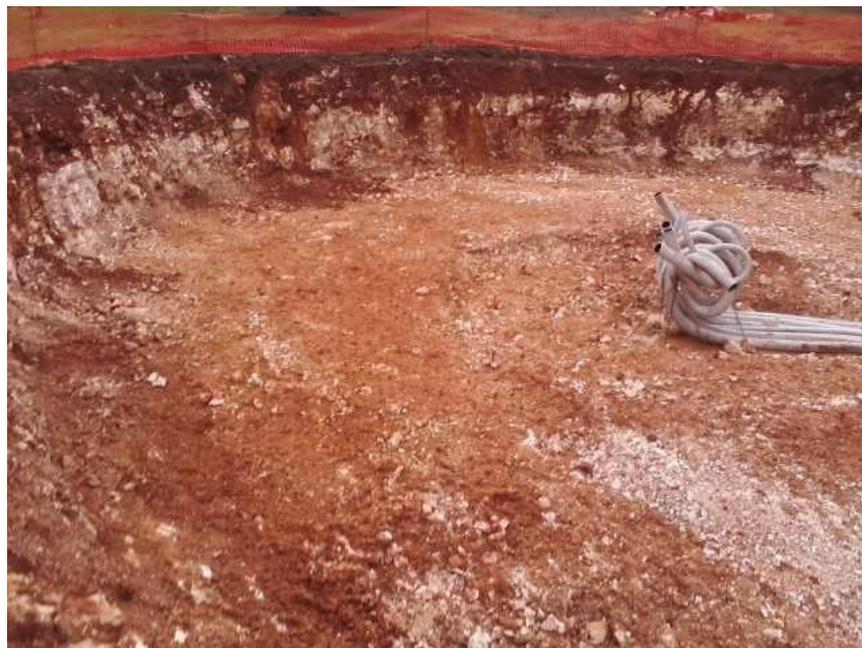
Figura 27: Particolare scavo di sbancamento per fondazioni WTG.
