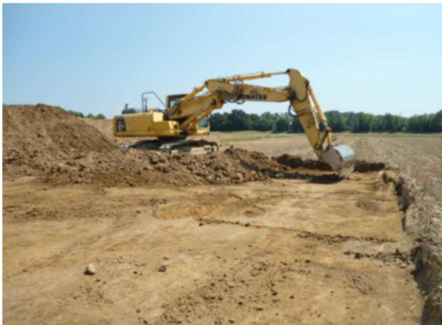
Figura 26: Particolare operazioni di scotico del terreno superficiale.
