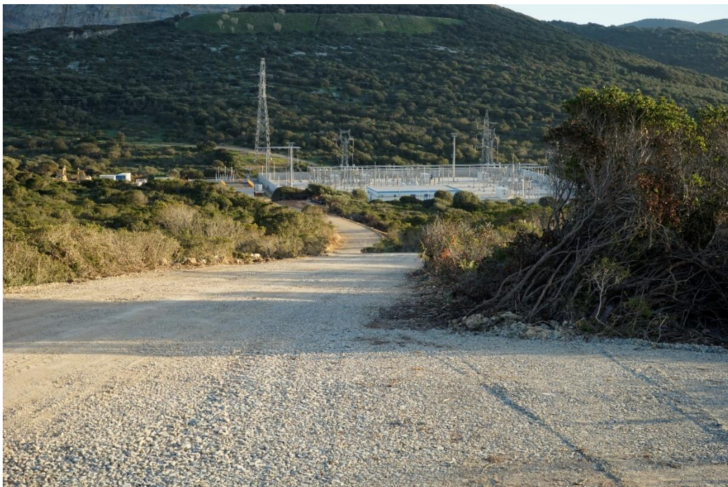
Figura 23: Strada interpodereale di collegamento con la Stazione Utente
