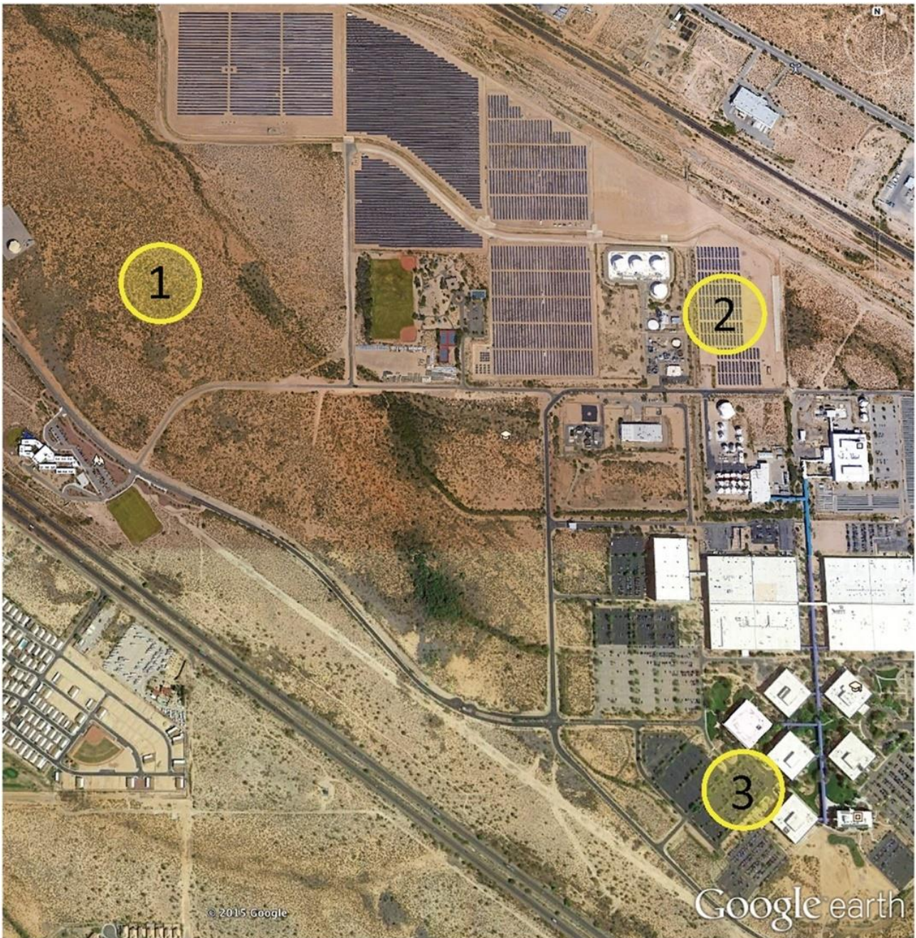
Figura 21 – Aree in cui sono avvenute le misurazioni presso l'UA Tech Park : il monitoraggio di un (1) ecosistema desertico semiarido naturale, (2) un impianto fotovoltaico solare (FV) e (3) un parcheggio "urbano" (The Photovoltaic Heat Island Effect: Larger solar power plants increase local temperatures)
