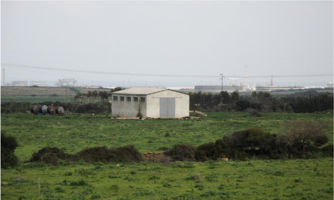
Figura 8.1: Edificio esistente per il ricovero dei mezzi agricoli, ubicato nell'area N. 2
