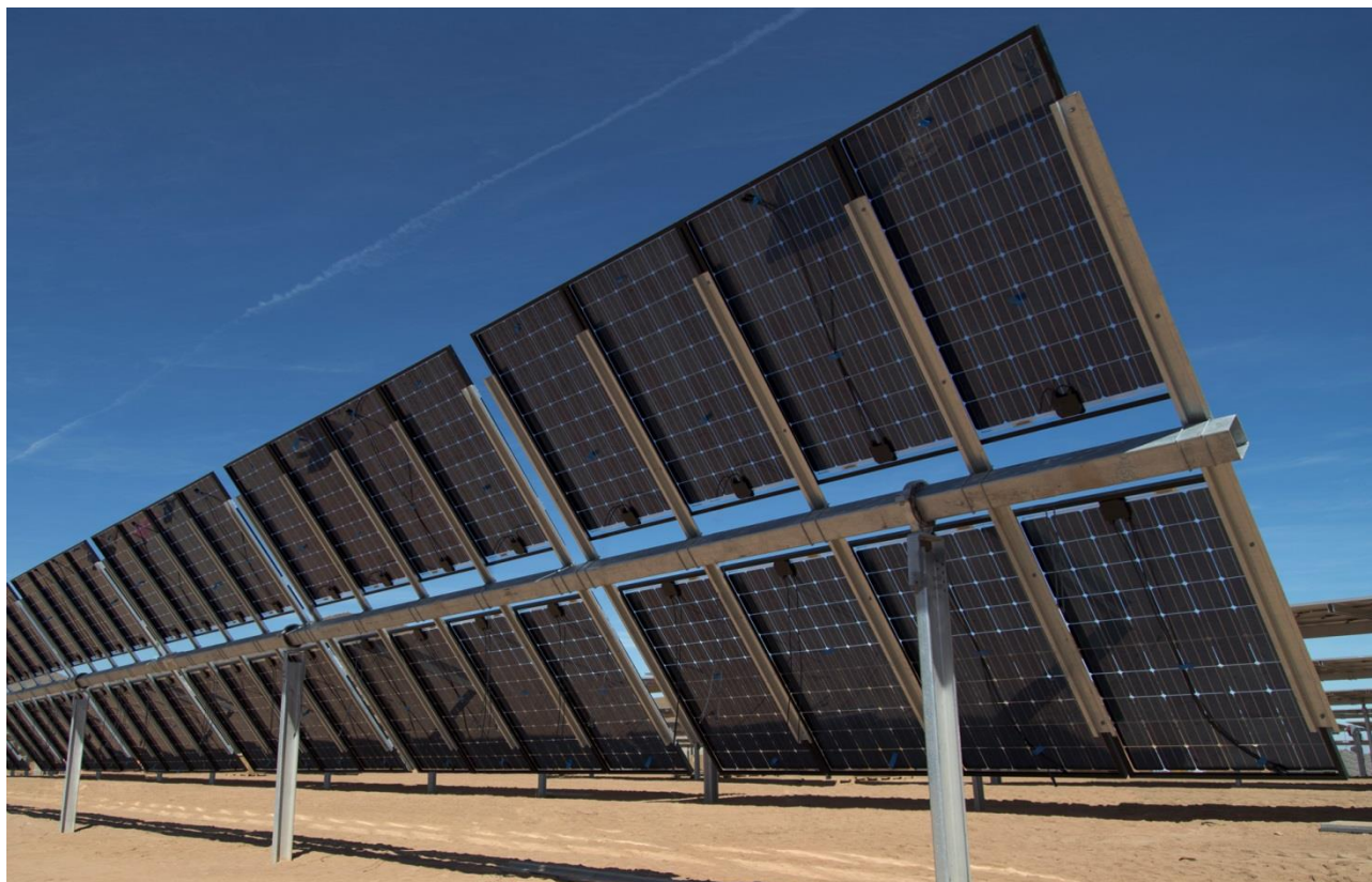
Figura 7.5: Esempio struttura e modulo FV bifacciale
