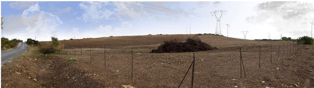
Figura 27- Area di intervento (Area 3)
