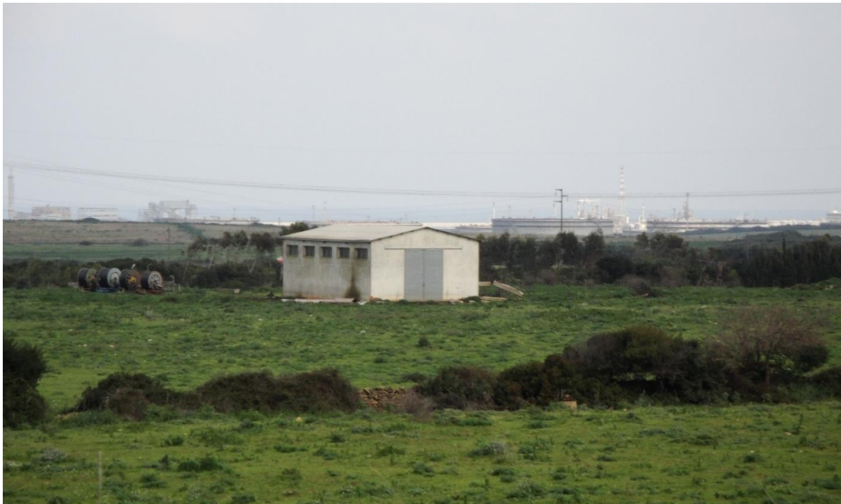
Figura 8- Edificio esistente presso Area n.2
