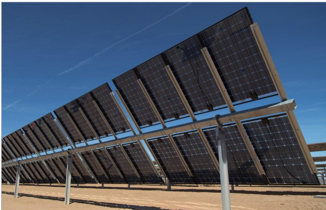
Figura III.3- Esempio struttura + modulo FV bifacciale
