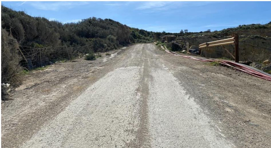
Figura II.23- Punto Foto N. 5 – Vista della strada esistente ricadente nella particella 596 del foglio 16
