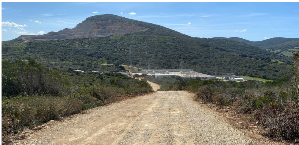
Figura II.20- Punto Foto N. 3 – Vista della strada esistente nella particella 129 del foglio 16
