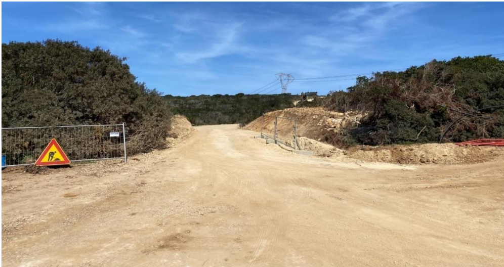
Figura II.18- Punto Foto N. 1 – Vista della strada esistente nella particella 76 del foglio 16
