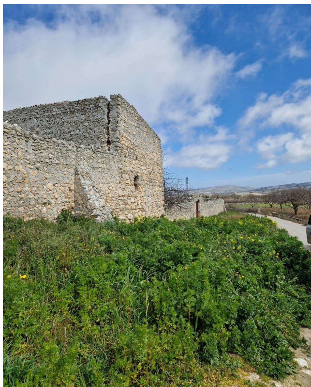
Fig. 06 – Vista del lato sud est della Masseria Donato
