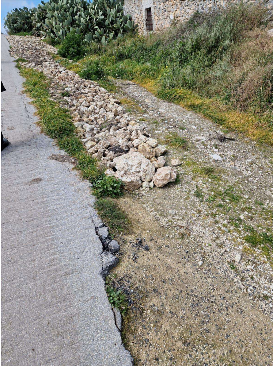
Fig. 07 – particolare della strada di accesso alla Masseria Donato
