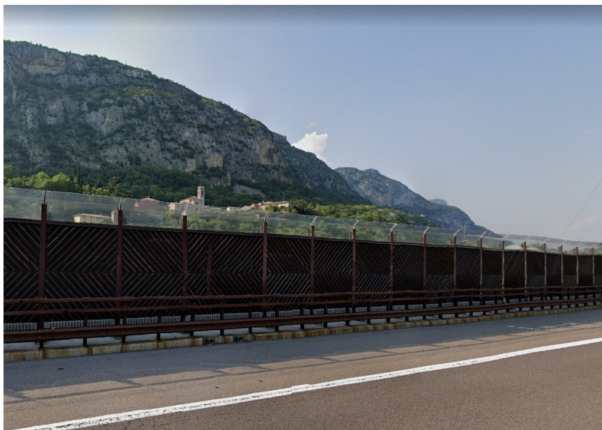
Impianto fonoassorbente già installato a protezione dell’abitato di Canale (vista da sud verso nord)
